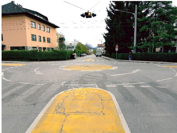
*Abb. 69: Falsche Verwendung von Richtungspfeilen in einem angedeuteten Kreisverkehr*
