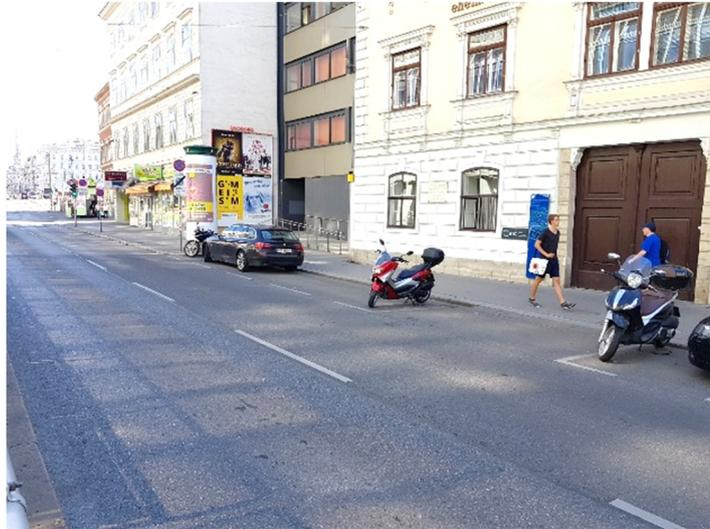
*Abb. 95: Falsche Bodenmarkierungen zur Abgrenzung von Parkflächen innerhalb einer Kurzparkzone*
