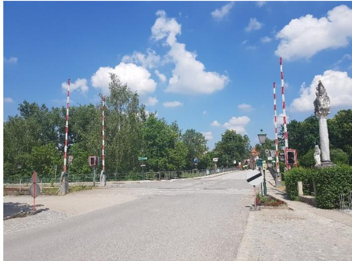
*Abb. 98: Unzureichende Absicherung eines beschränkten Eisenbahnüberganges*
