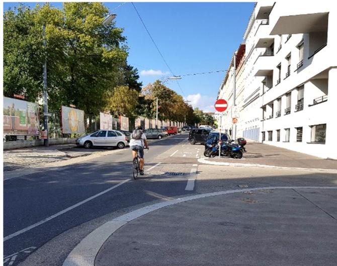
*Abb. 75: Schaffung unklarer Vorrangverhältnisse durch falsche Anbringung einer Begrenzungslinie*
