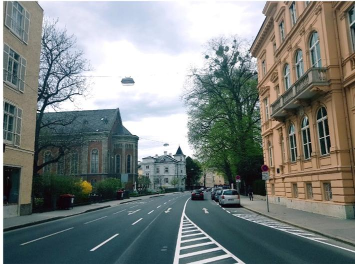
*Abb. 62: Unzureichende Trennung von mehreren Fahrstreifen auf Straßen mit Gegenverkehr*
