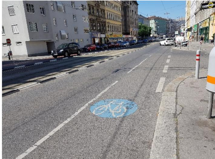
*Abb. 83: Unzulässige Kennzeichnung eines Mehrzweckstreifens*
