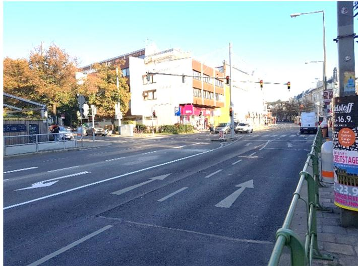
*Abb. 74: Verleitung von Verkehrsteilnehmern zum unzulässigen Linkseinbiegen*
