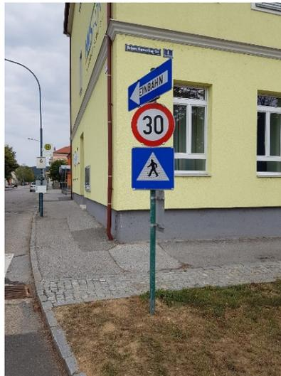
Abb. 63: Anbringung von mehr als zwei Straßenverkehrszeichen auf einer Anbringenvorrichtung
