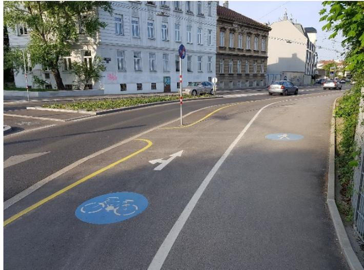
*Abb. 93: Verwendung von gelben Bodenmarkierungen als Randlinie eines Radweges*
