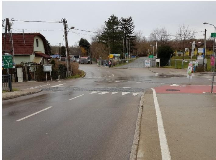
*Abb. 81: Falsche Verwendung von Ordnungslinien zur Kennzeichnung einer Querungsstelle für Radfahrer und Anbringung eines ungeeigneten Gefahrenzeichens*
