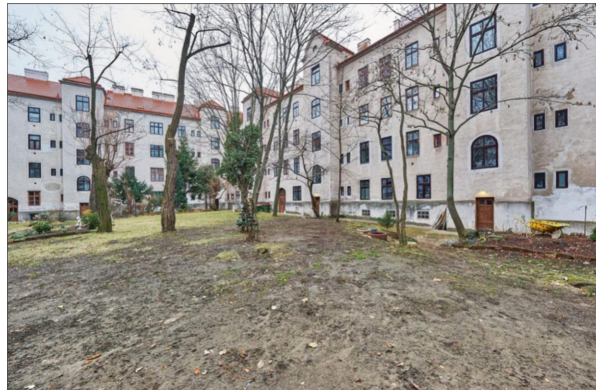
Abbildung 19: Aufnahme Innenhof in Himmelsrichtung West
