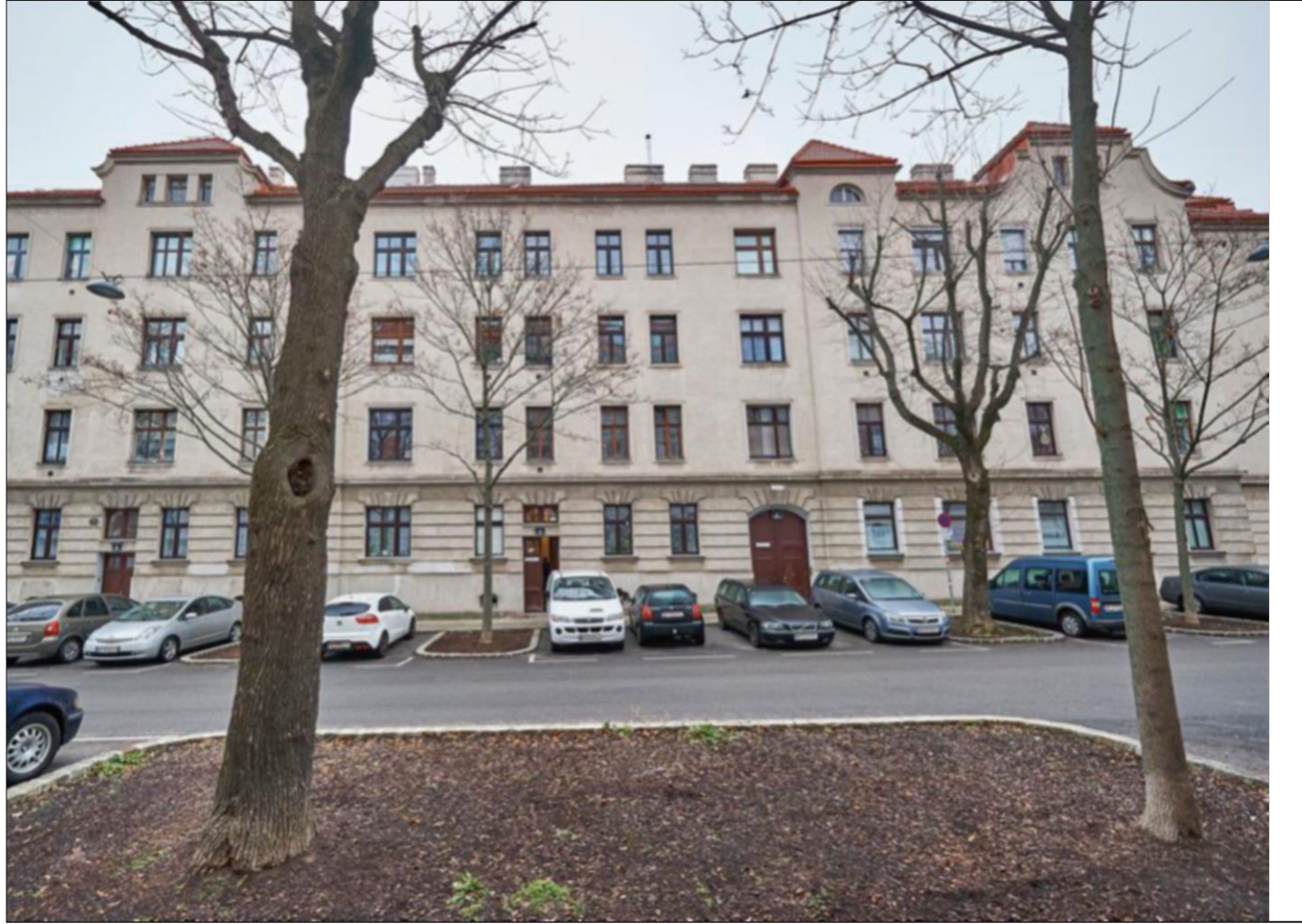
Abbildung 9: Fotodokumentation Fassade Roseggergasse 2-8, 1160 Wien
