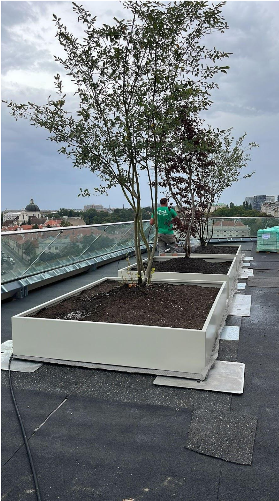
Abbildung 16: Projekt Schwarzenbergplatz 13: Lastverteilerplatten [50]
