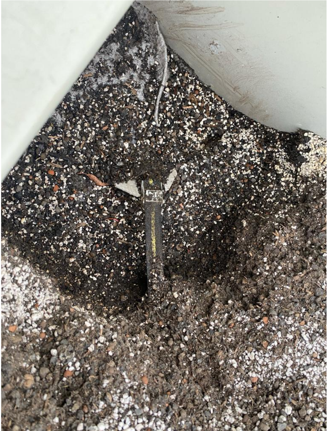
Abbildung 19: Projekt Schwarzenbergplatz 13: Ankerung [50]
