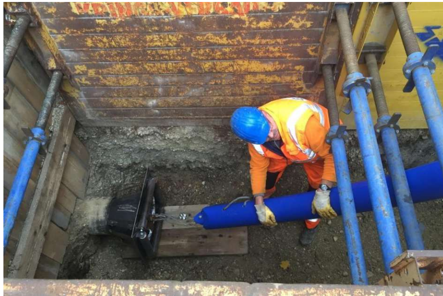
Abb. 4.6: Offene Startgrube ausgepölt 93
