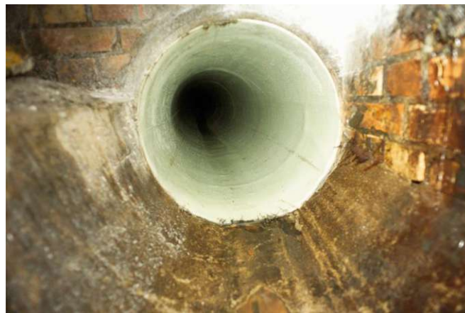
Abb. 5.10: Fertiggestellte Linersanierung 112
