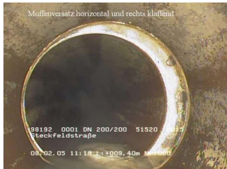
Abb. 5.3: Schadensbild Muffenversatz 99
