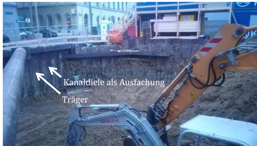
Abb. 3.6: Ausgesteifter Trägerverbau mit Kanaldielenausfachung 65
