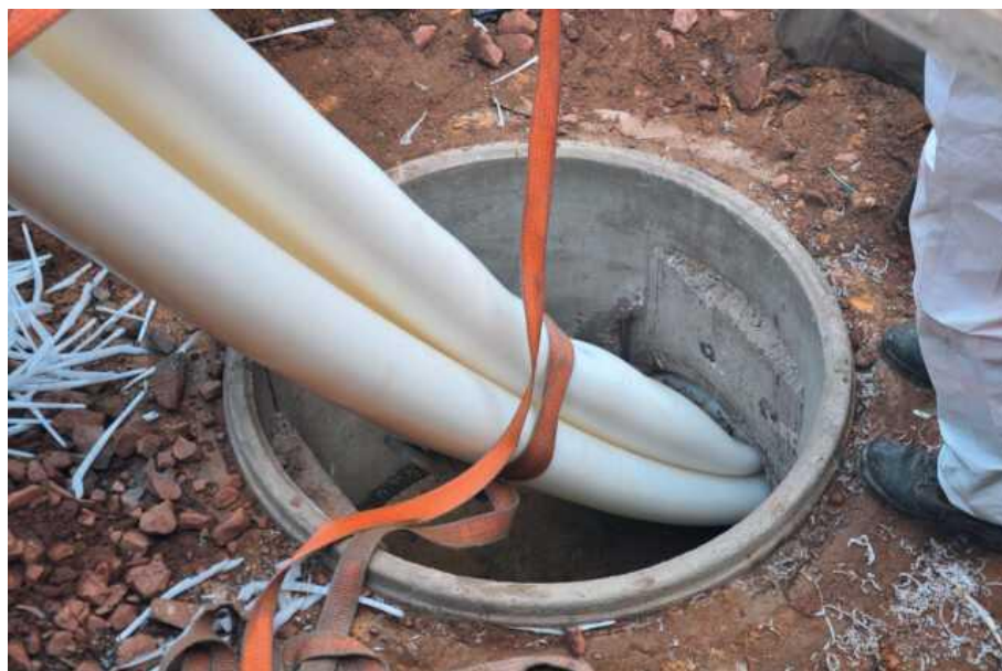
Abb. 4.7: Verwendung eines Bestandschachtes beim Verfahren „verformten Rohre“ 94
