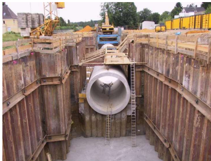
Abb. 3.5: Verbauter Graben mit Spundwand, Gurtung und Rückverankerung 62
