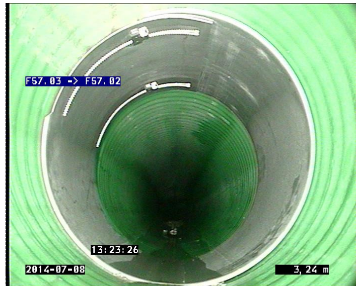
Abb. 5.35: Sanierungsbild einer Edelstahlmanschette mit mechanischer Vorrichtung 184
