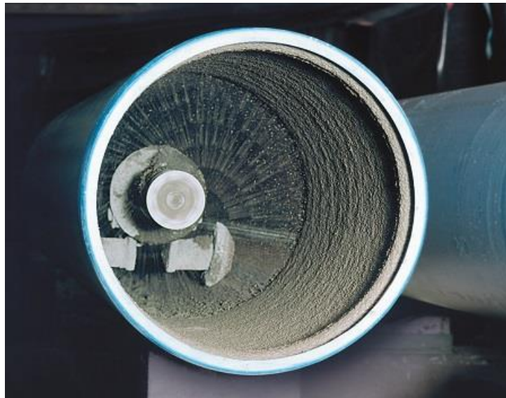
Abb. 5.21: Innenwandauskleidung aus Zementmörtel 139
