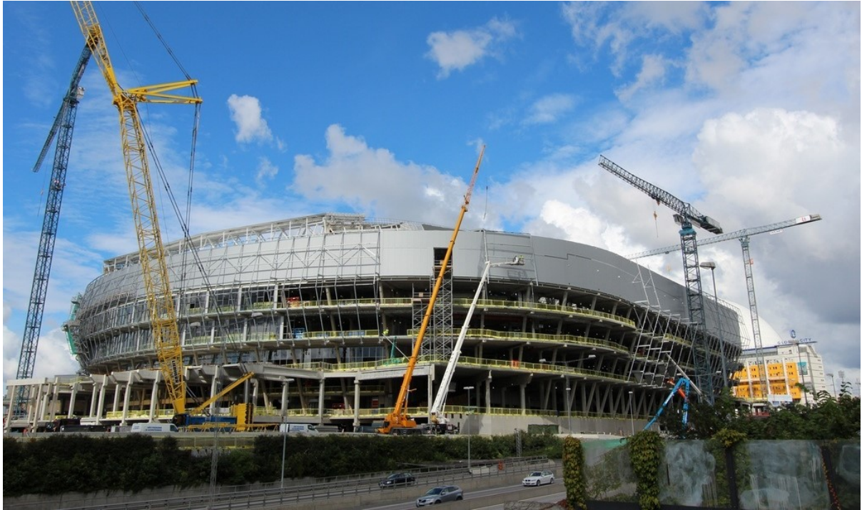
Abb. 2.34: Einsatz von Turmdrehkränen in Kombination mit Mobilkränen 53
