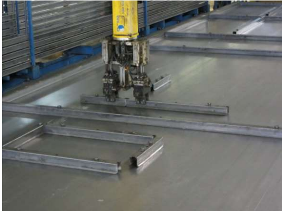
Abb. 2.12: Schalungsroboter im Einsatz
