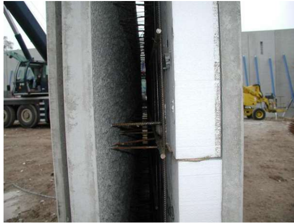
Abb. 2.39: kerngedämmte Hohlwand 63
