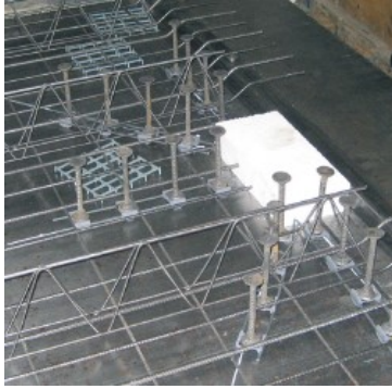
Abb. 2.22: Durchstanzbewehrung 42
