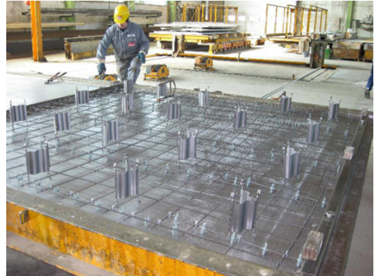
Abb. 2.43: Einbau Kap-Stahl-Welle 67
