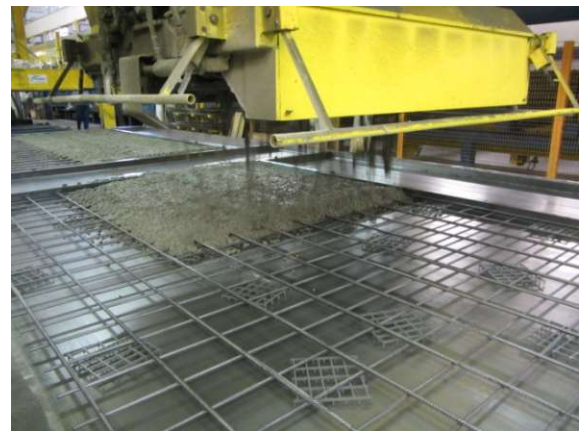
Abb. 2.26: Betonage mittels Betonverteiler
