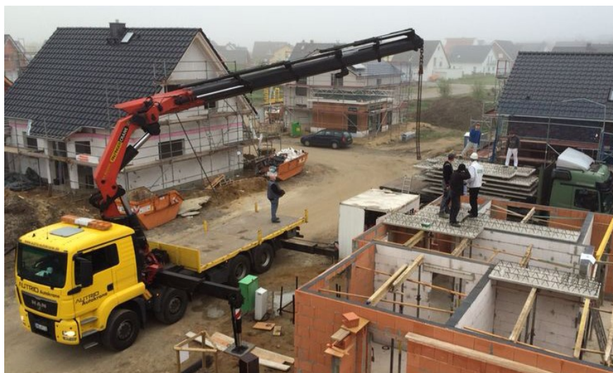
Abb. 2.35: Verlegung einer Elementdecke mittels Fahrzeugkran 54
