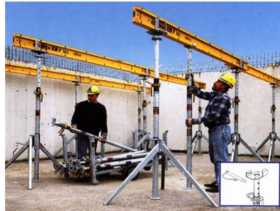
Abb. 4.9: Einschalen Ortbetondecke (2)
