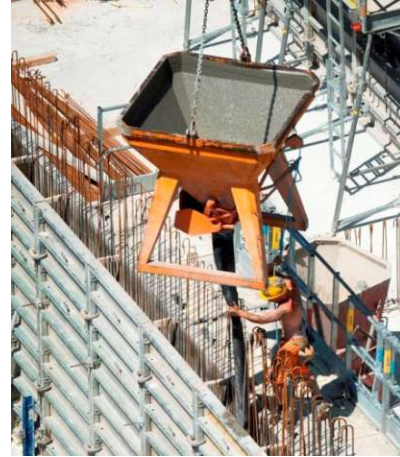
Abb. 3.13: Betoneinbau mit Kran und Kübel 112
