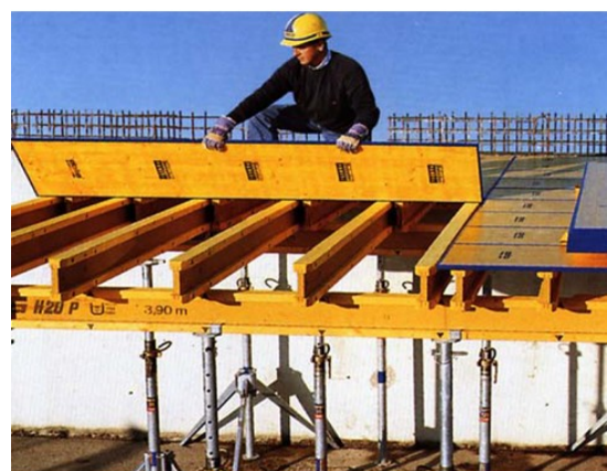
Abb. 4.11: Einschalen Ortbetondecke (4)
