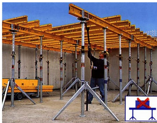
Abb. 4.10: Einschalen Ortbetondecke (3)
