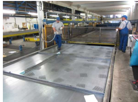
Abb. 2.15: Schalung mit Trennmittel versehen
