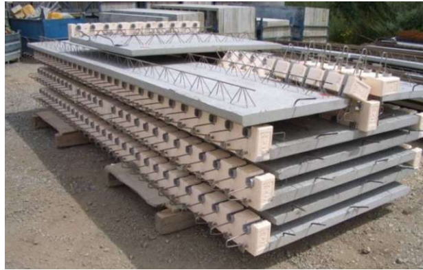
Abb. 4.3: Lagerung Elementdecke auf der Baustelle 130
