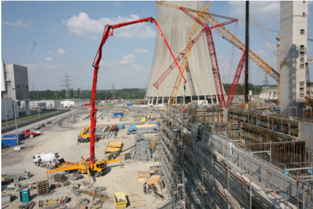
Abb. 3.14: Betoneinbau mithilfe einer Autobetonpumpe 114
