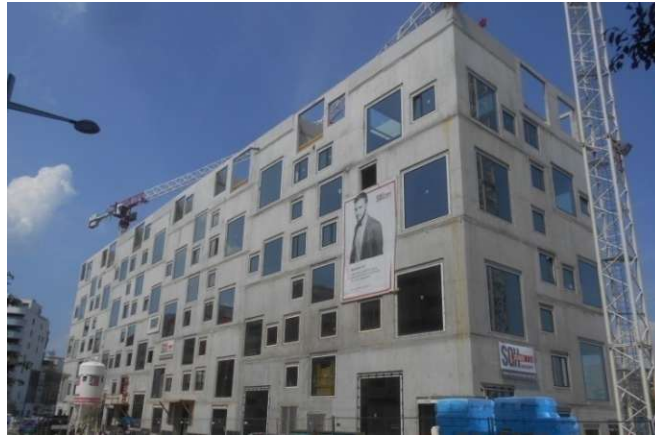
Abb. 1.1: Ortbetonbauweise
