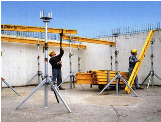
Abb. 4.8: Einschalen Ortbetondecke (1) 137
