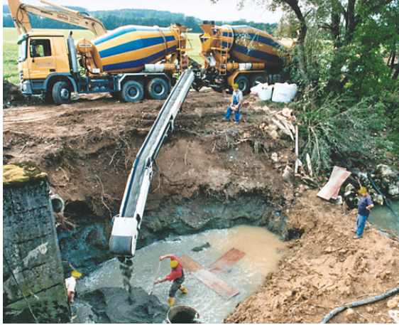
Abb. 3.12: Betoneinbau mittels am Fahrmischer integrierten Förderband 111
