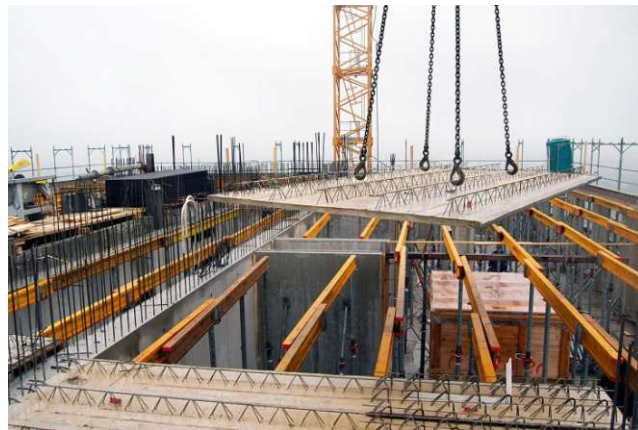
Abb. 4.7: Versetzen einer Elementdecke 134
