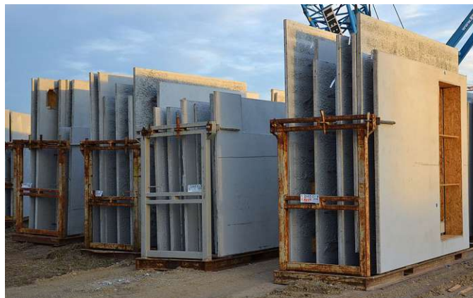
Abb. 4.4: Lagerung Hohlwand auf der Baustelle 131
