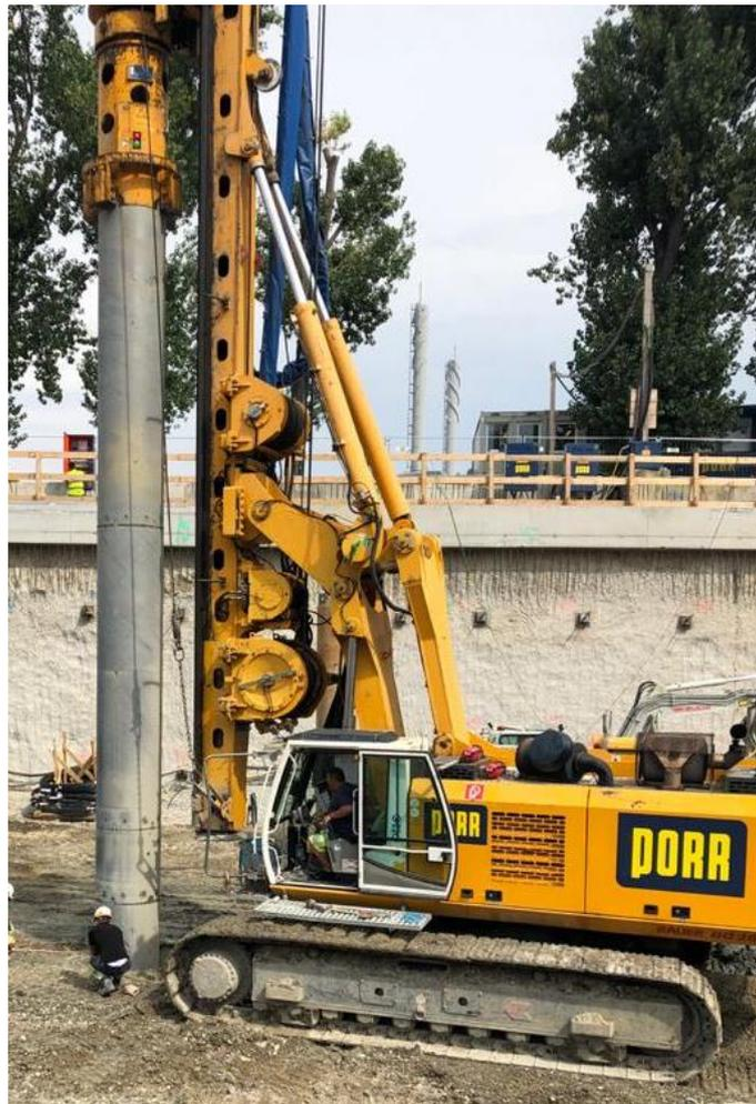
Abbildung 52: Großdrehbohrgerät Bauer BG28H
