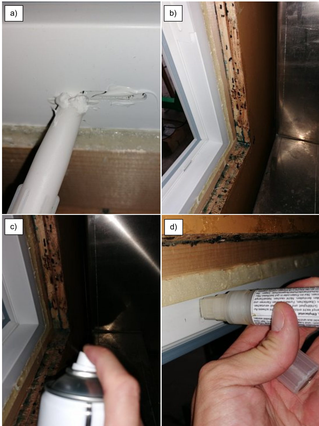
Abbildung 8.4.: Vorbereitungsarbeiten für Folienabdichtung
