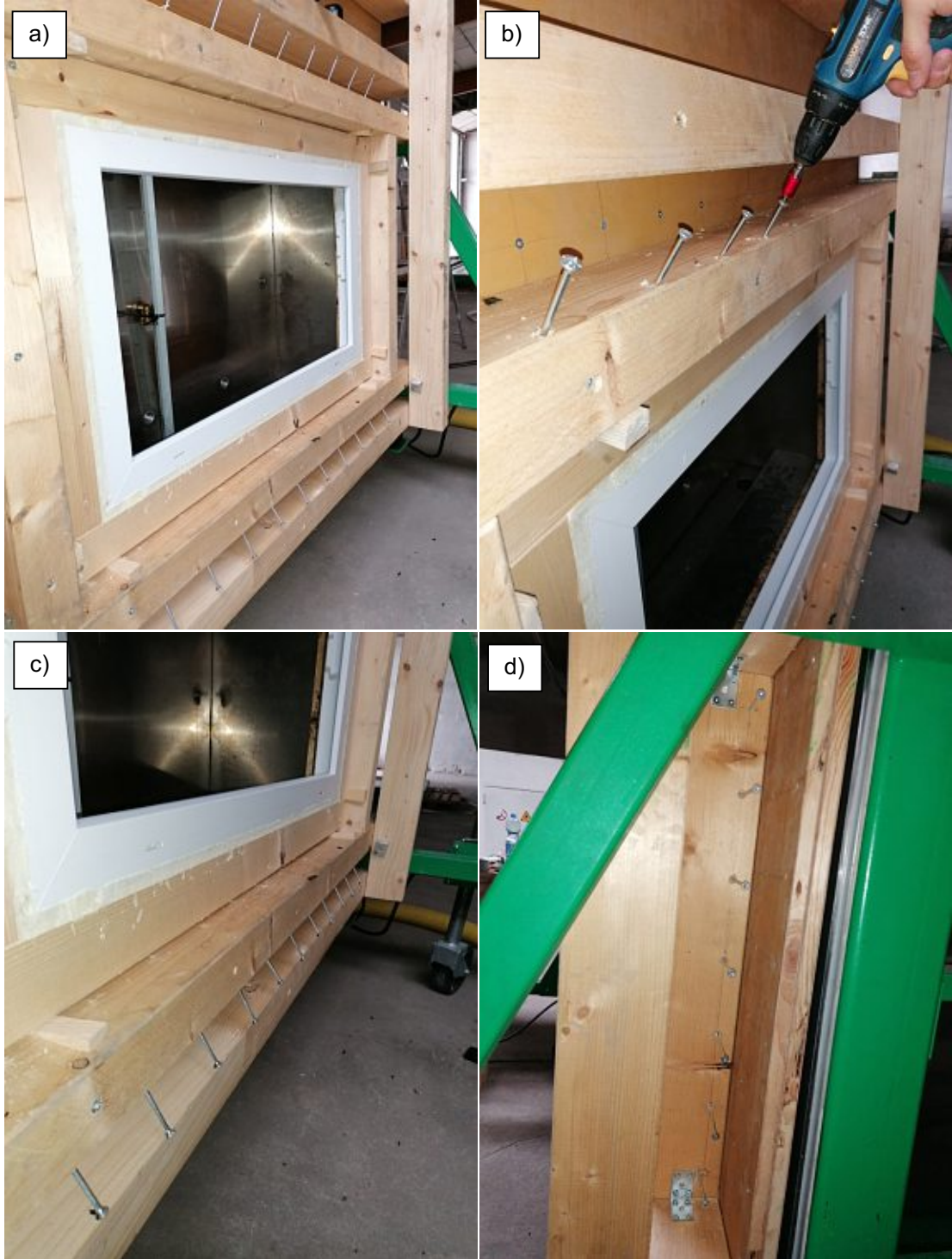
Abbildung 8.3.: Fenstermontage im Versuchsrahmen
