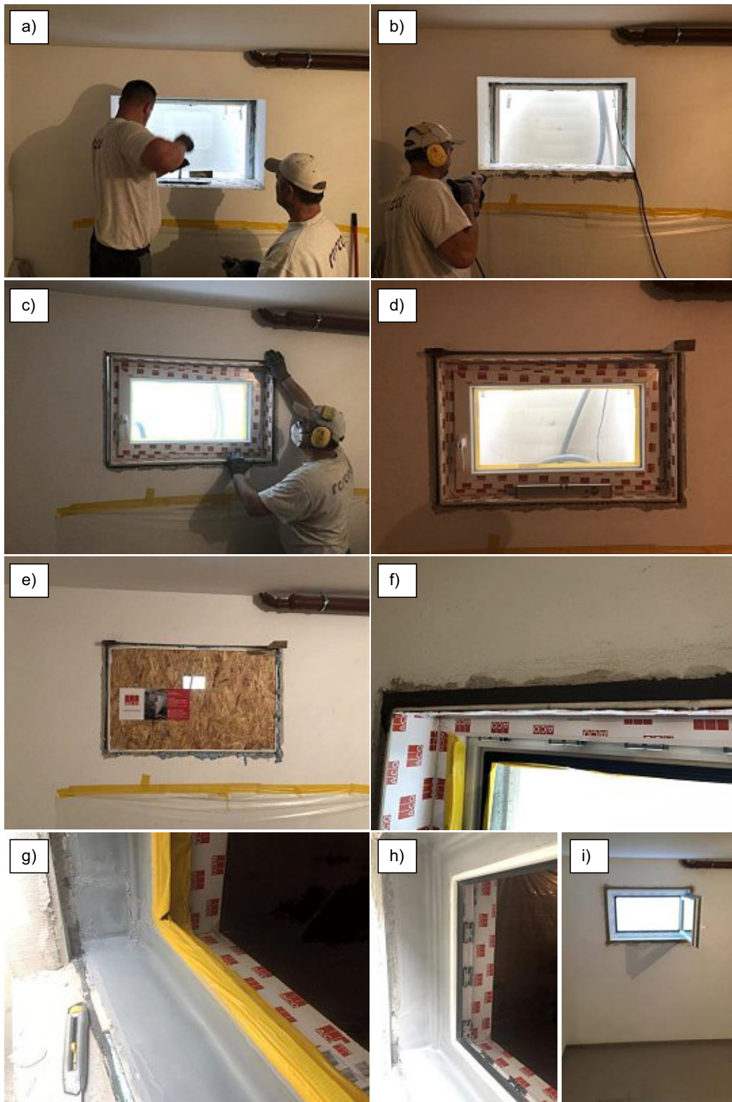
Abbildung 5.10.: Fenstertausch Fa. Rascor [4]
