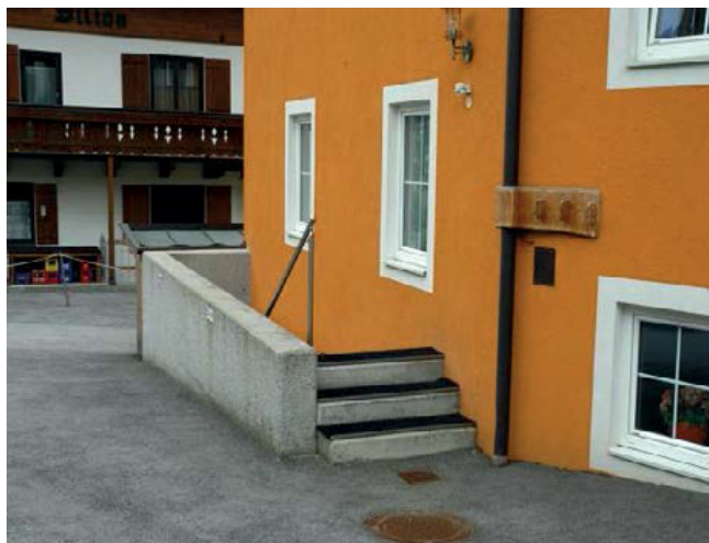
Abbildung 5.11.: Hochgezogener Mauersockel bei Kelleraußentreppe [5]
