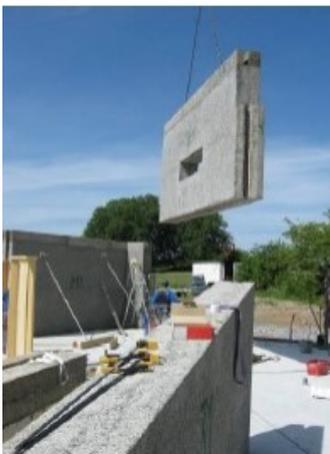
Abb. 65 Holzleichtbetonwandelement [39]
