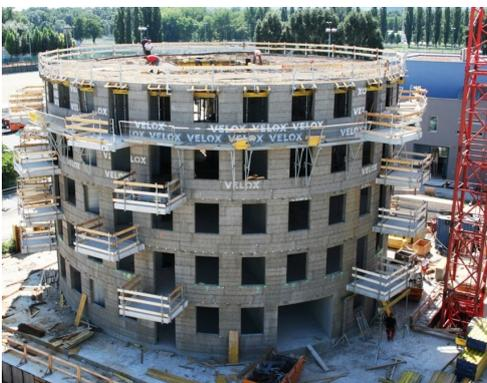
Abb. 15 Außenwandkonstruktion mit Holzleichtbeton [35]
