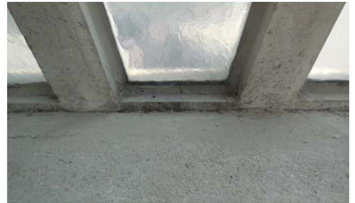
Abb.34: Bodenanschluss Fertigteilelement
