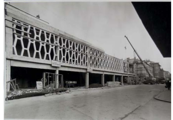
Abb.26: Errichtung der Fassade mit Betonfertigelementen, 1968
