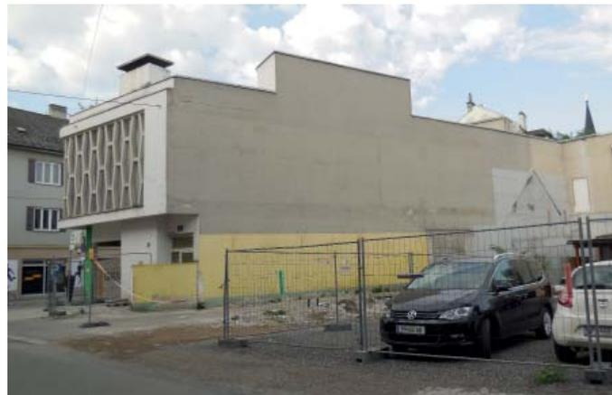
Abb.19: Brandschutzmauer als nördlicher Gebäudeabschluss
