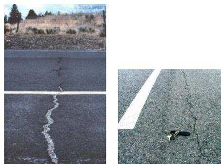
**Abb. 10 - links: versiegelter Riss quer zur Fahrbahn (WAPA 2018); rechts: Längsriss infolge starker Abkühlung und Verkehrsbelastung (Wistuba 2006)**
