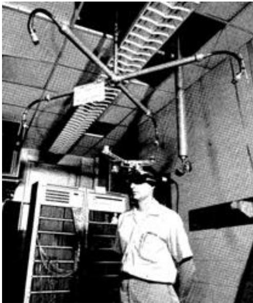
Abb. 6: ein Nutzer des Head-Mounted Displays, das wegen seines Gewichts an die Decke geschraubt werden musste (Sutherland, 1968)
