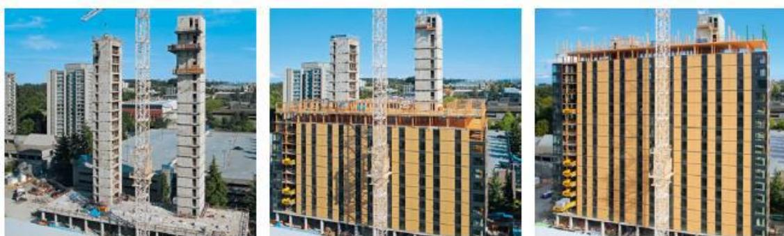
Abbildung 8: Erschließungskern aus Stahlbeton [1]
