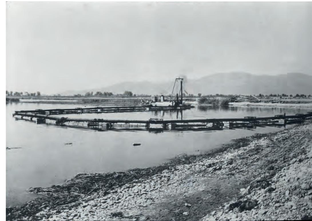
Abb. 19: 1960, Sanierung der Harder Bucht, Saugbaggerung im Binnenbecken
