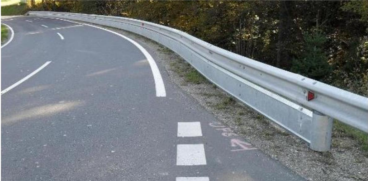
**Abbildung 3: Leitschienen Unterfahrschutz<sup>17</sup>**
