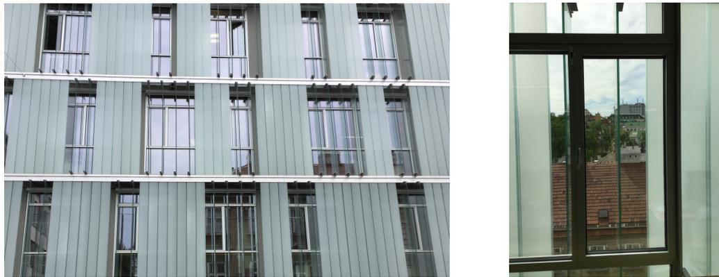
*Abbildung 7: Doppelfassade von außen und innen mit den drehbaren Glaslamellen vor den Drehflügelfenstern*
