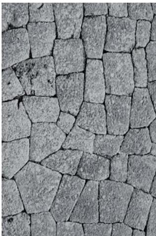
Abb 02: Zyklopenmauerwerk
