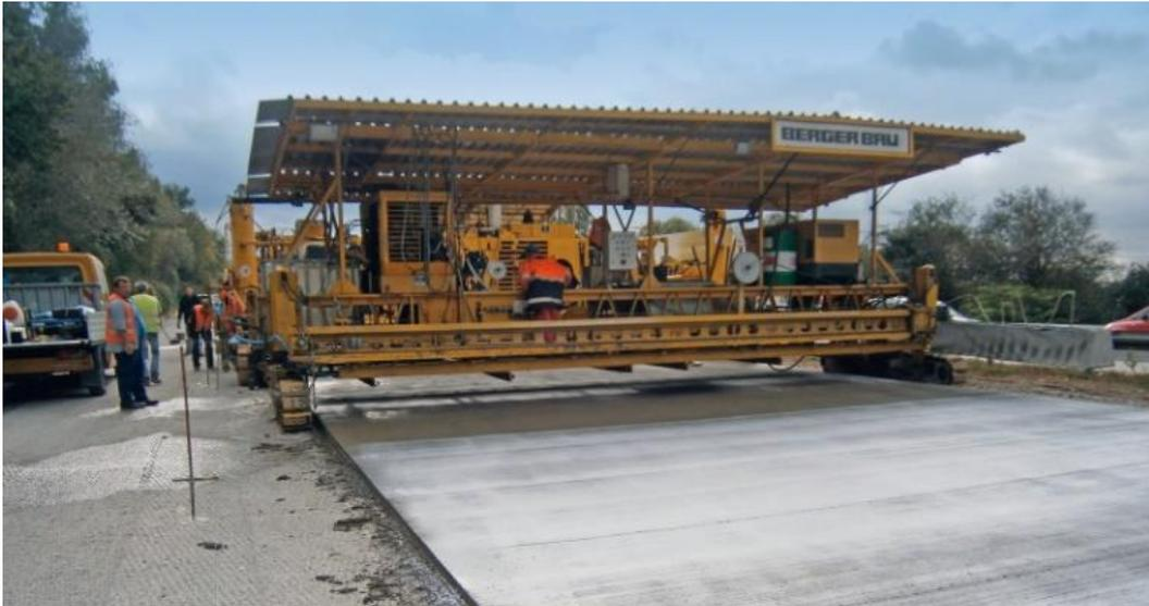
Abb. 4: „Whitetopping: Instandsetzung bzw. Ertüchtigung von geschädigten oder unterdimensionierten Decken aus Asphalt oder Beton“<sup>8</sup>
