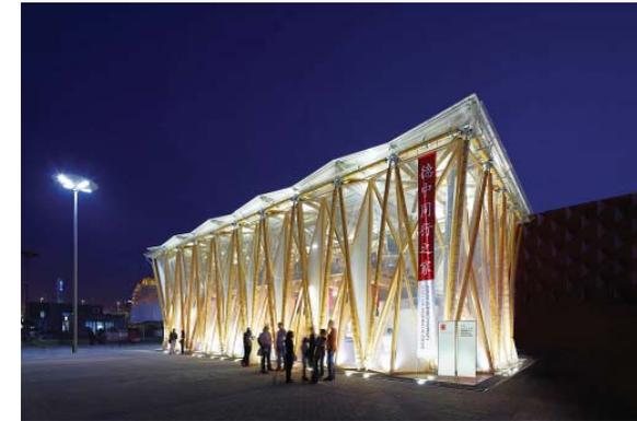
**Abb. 180** Deutsch-Chinesischer Pavillon, EXPO 2010 Shanghai: Bambusbauwerk mit PVC-Membrandach und ETFE-Membranfassade, Künstler Markus Heinsdorff
