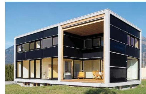
**Abb. 31** Fassadenintegration von Solarkollektoren,
