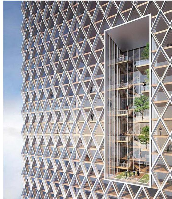
**Abb. 118** Durch eine Netzkonstruktion sollen die Stärken des Baustoffs Holz voll ausgereizt werden
