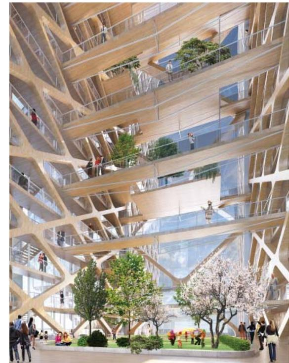
**Abb. 121** Kreuzweise angeordnete Holzstützen im Inneren steifen das Gebäude aus
