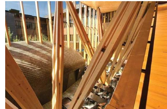
**Abb. 68** Jede Säule besteht aus vier gebogenen Trägern, die in Form geklebt und mit Stahlplatten und Schrauben verbunden sind
