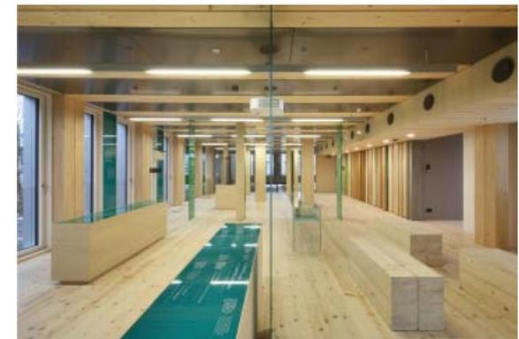
**Abb. 81-84** Holzrahmenkonstruktion (Holz-fertigteil-Baukastensystem) mit Doppelstützen und Leimbinder
