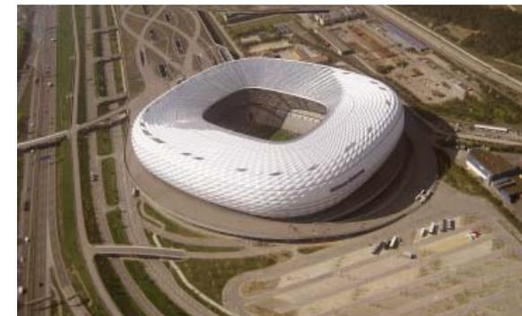
**Abb. 181** Allianz Arena München, 2005, Herzog & de Meuron: Fassade besteht aus pneumatisch vorgespannten, extrem transparenten Kissen aus ETFE-Folie, die eine Lichtdurchlässigkeit von 93% aufweisen.
