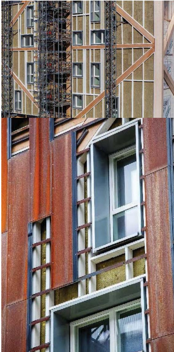
**Abb. 113** Metallverkleidung während der Errichtung
