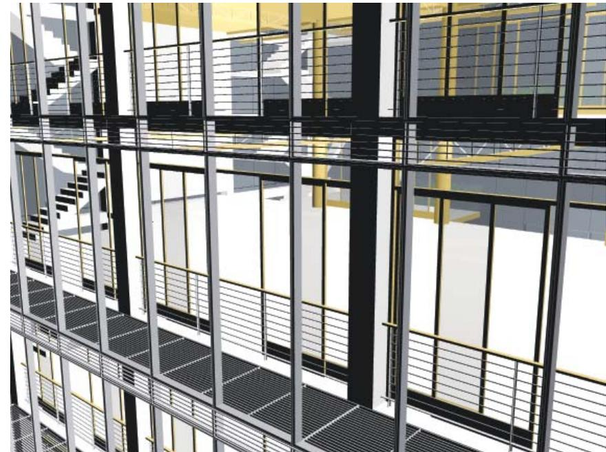
**Abb. 245-246** Nordfassade. Die Fassade besteht aus einer zweischaligen Haut (ESG außen und Isolierverglasung innen). Die äußere Schale ist fest verglast. Die regelbaren Lüftungsklappen befinden sich im Attika- und Fußbereich. In der inneren Haut sind Schiebetüren untergebracht, so daß jeder Nutzer sein individuelles Klima schaffen kann.
