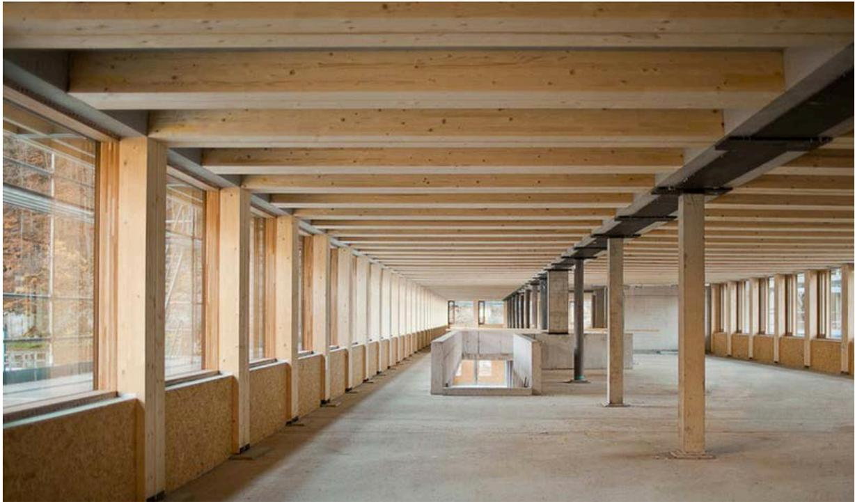
Abbildung 32: Rohbau: Deckenelemente werden in der Mittelachse von Stahlträgern gehalten, welche auf einer Reihe Stahlbetonsäulen gestützt sind.
