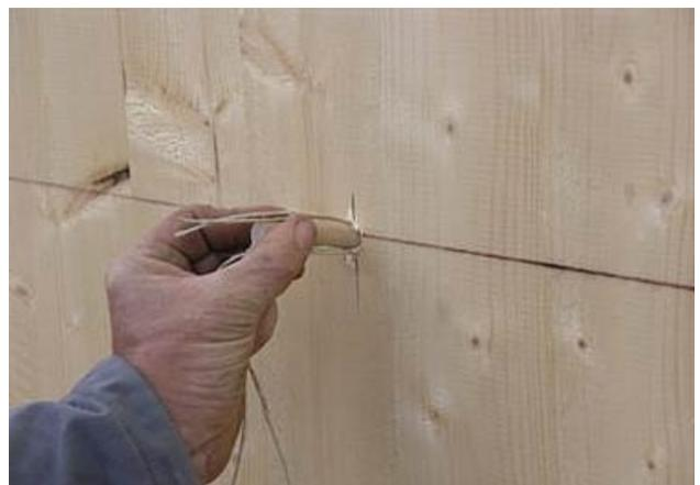
Abbildung 50: Befestigung der Schnüre mittels Holzdübel
