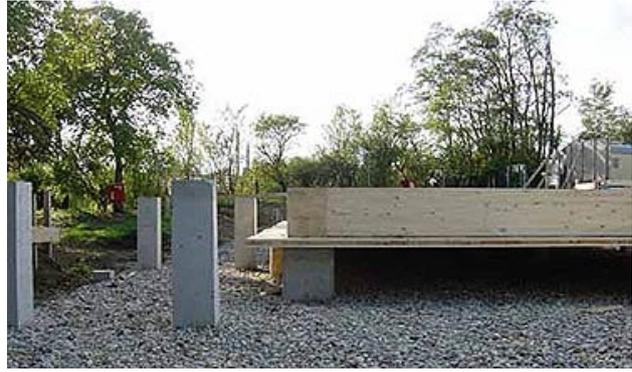
Abbildung 48: BSP- Bodenplatte auf Punktfundamente gelagert
