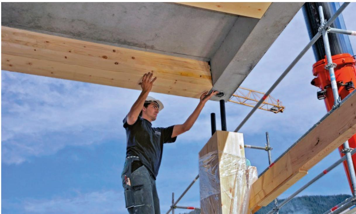
Abbildung 31: Die Doppelstützen sind mit den HBV-Deckenelementen gegen das Ausziehen über Rohr-Dorn-Steckverbindungen gesichert. Dieses Prinzip der Rohbaukonstruktion sichert die vertikale Maßhaltigkeit des Gebäudes und garantiert die planmäßige und zügige Höhenentwicklung
