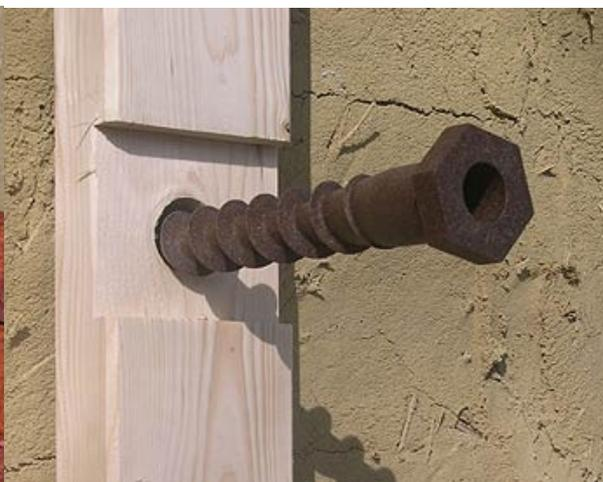
Abbildung 52: Befestigung der Lattung (Hinterlüftungsebene) auf die lehmverputzte Fassade
