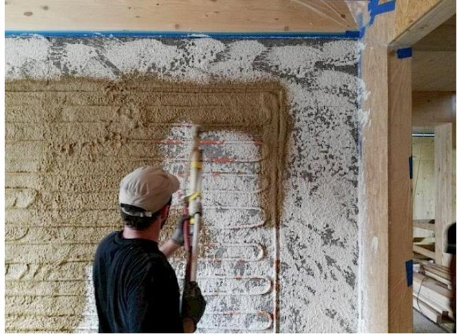
Abbildung 57: Lehmverputz auf Strohwand mit montierter Wandheizung.
