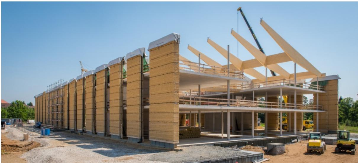
Abbildung 41: STB- Säulen+ Geschosßdecken, BSH- Leimbinder als Dachkonstruktion und die selbsttragenden Stampflehmwände
