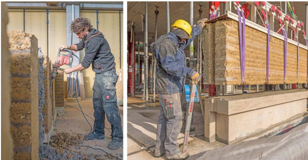
Abbildung 44: Einschlagen der Nuten für Fensteranschluss und Regenabfallrohre sowie Montage der 1. Reihe Stampflehmwände auf dem STB- Sockel
