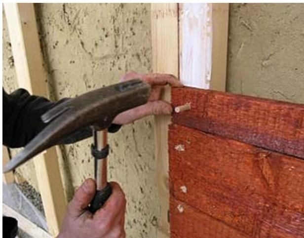
Abbildung 53: Mechanische Befestigung der Fassade
