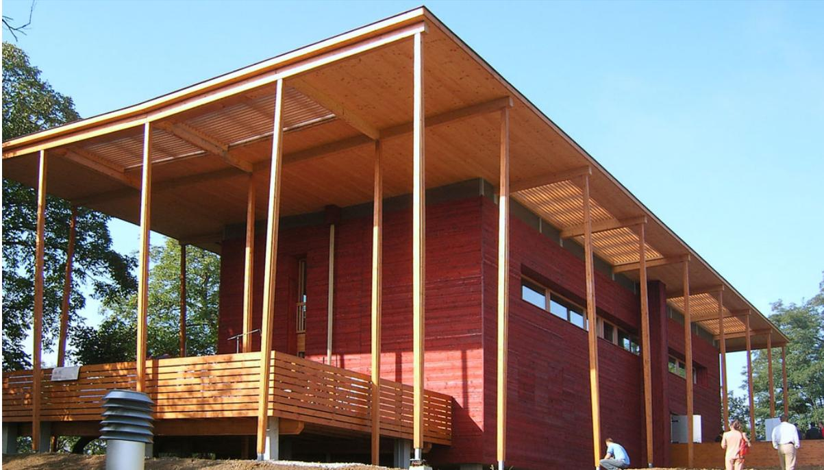
Abbildung 47: S- House, Böheimkirchen: Das weit auskragende Dach bildet den konstruktiven Holzschutz für die darunter eingestellte Holz- Stroh- Lehm Box.
