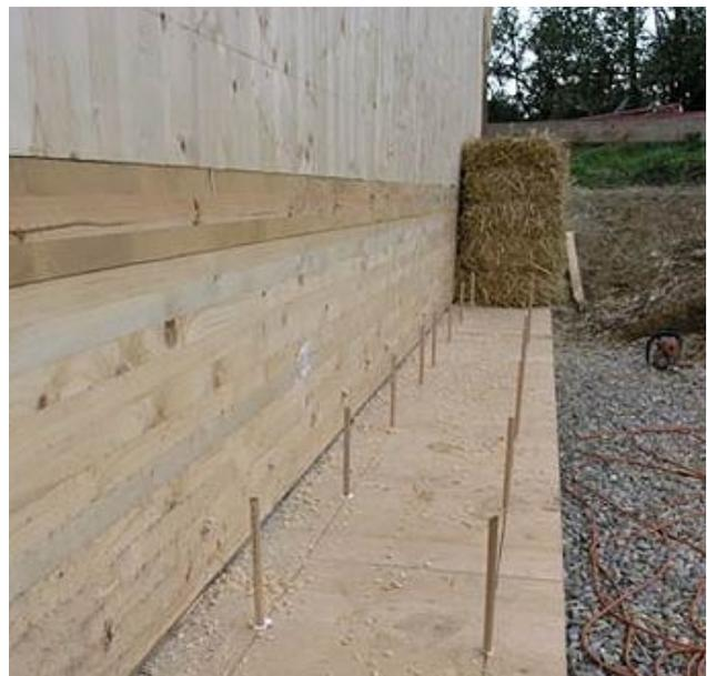
Abbildung 49: Montage der Strohballen-Verbindung untereinander mittels Rundhölzer
