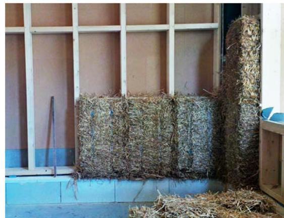
Abbildung 56: Primär- Skellettstruktur überspannt die Querachse+ Einbringung der Strohballen
