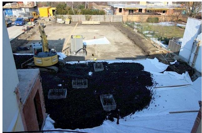
Abbildung 55: Einbringung des Glasschaumschotters anstatt XPS Dämmung
