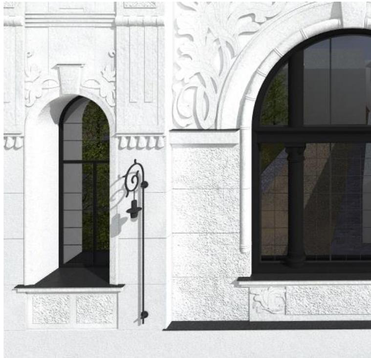
Abb. 95: Unterscheidung glatter und rauher Putz
