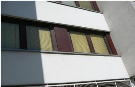
Abb. 48: Stirnseite mit Wärmedämmung und Putz, neue Fenster mit Rahmen, Drehkipplügel
