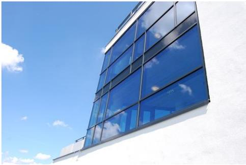
Abb. 99: Hauptstiegenhaus in Pfosten-Riegel-Konstruktion
