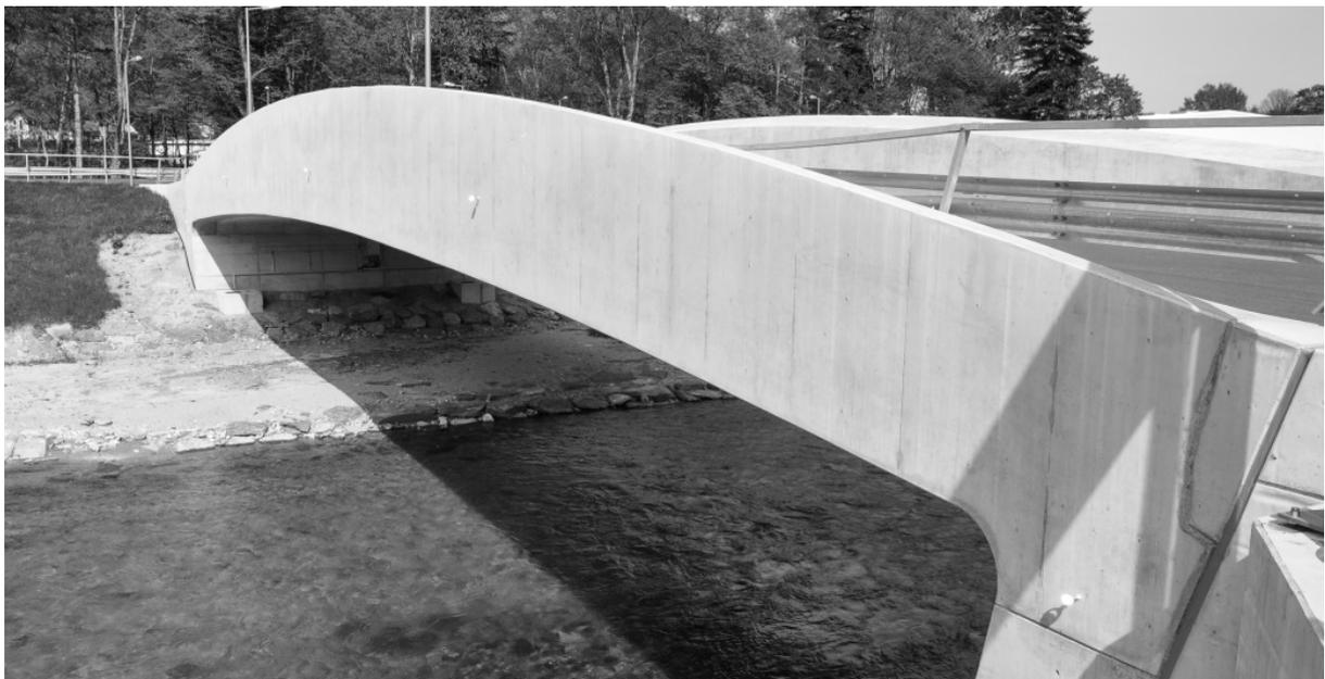
Abbildung A.2-6: Der vorgespannte Trogquerschnitt spannt über 40 m als zusammenhängende Funktionseinheit über den Fluss Schwarza. Die Gurtoberflächen sind abgeschrägt, um ein Befahren zu verhindern.
