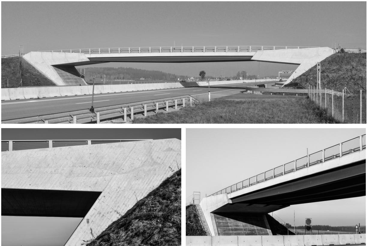
Abbildung A.1-7: Verbundrahmen mit einer expressiven Rahmeneckausbildung. Das statische System wird in der Form exakt wiedergespiegelt.
