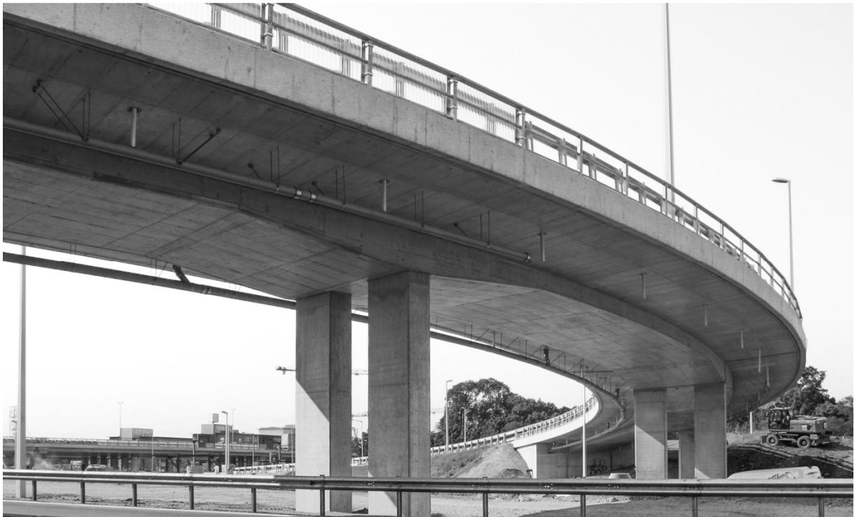
Abbildung A.2-2: Die Stützen der gekrümmten, ca. 120 m langen integrale Brücke wurden absatzlos an die Voute als homogene Funktionseinheit angeschlossen.
