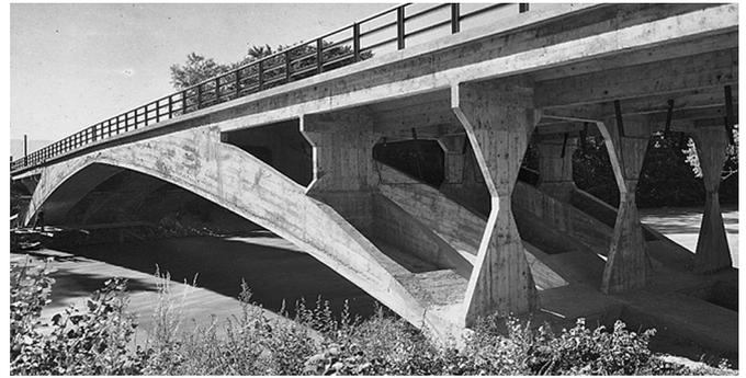
**Bild 13** Kunstvolles Überzeichnen der statischen Wirkung der Stützen bei der Brücke über die Arve bei Vessy
