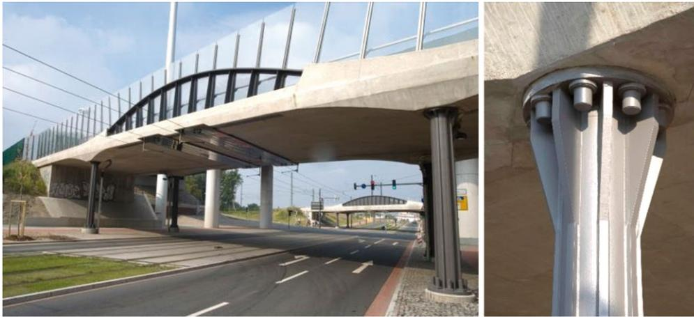
**Bild 13** Stephanitorbrücken in Bremen: Straßenbrücke im Vordergrund (links) mit dem Stützenanschluss bei der Eisenbahnüberführung (rechts)
