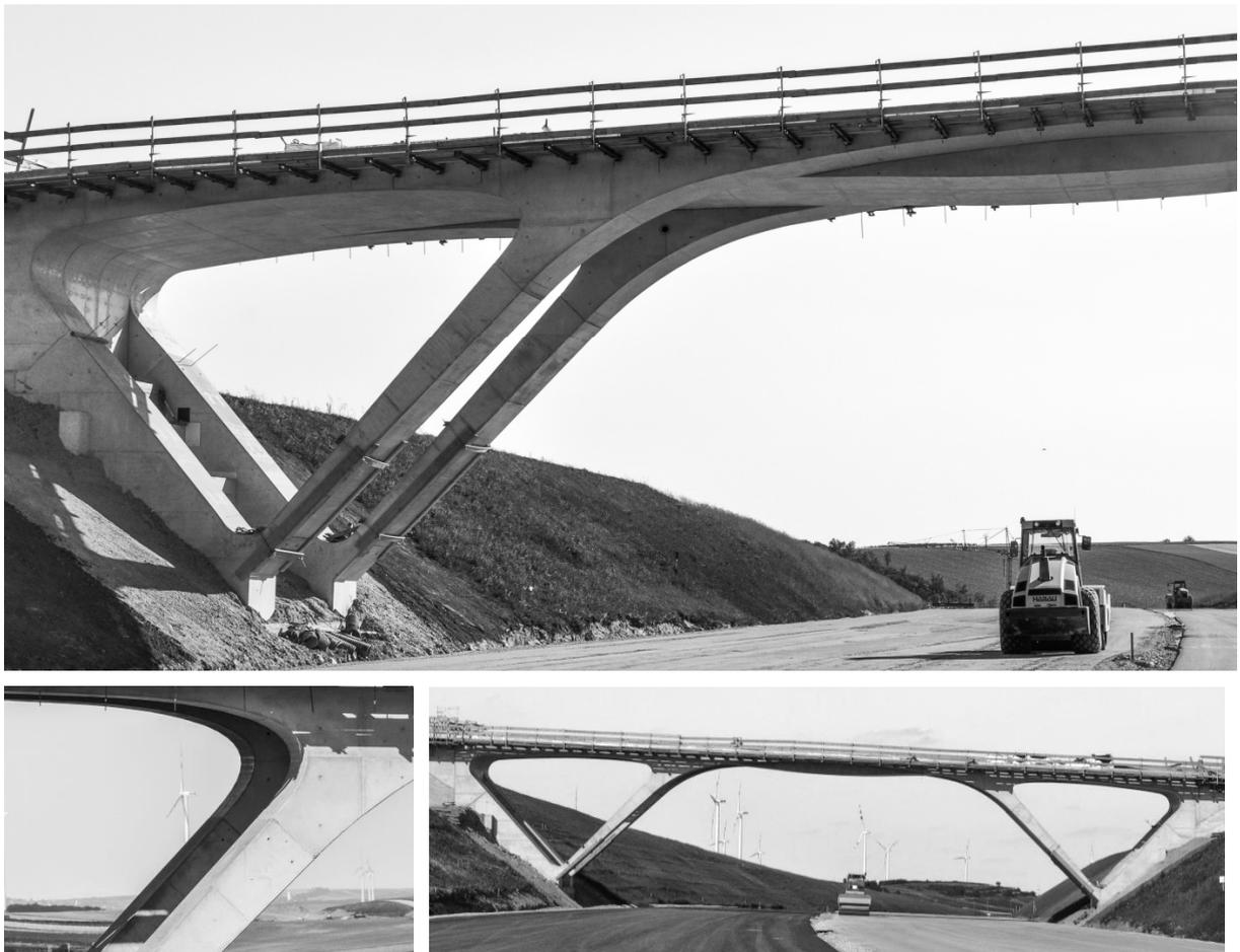
Abbildung A.1-6: Hohe Dynamik durch Schrägstiele und verschnittene konvexe und konkave Krümmungen im Überbau.
