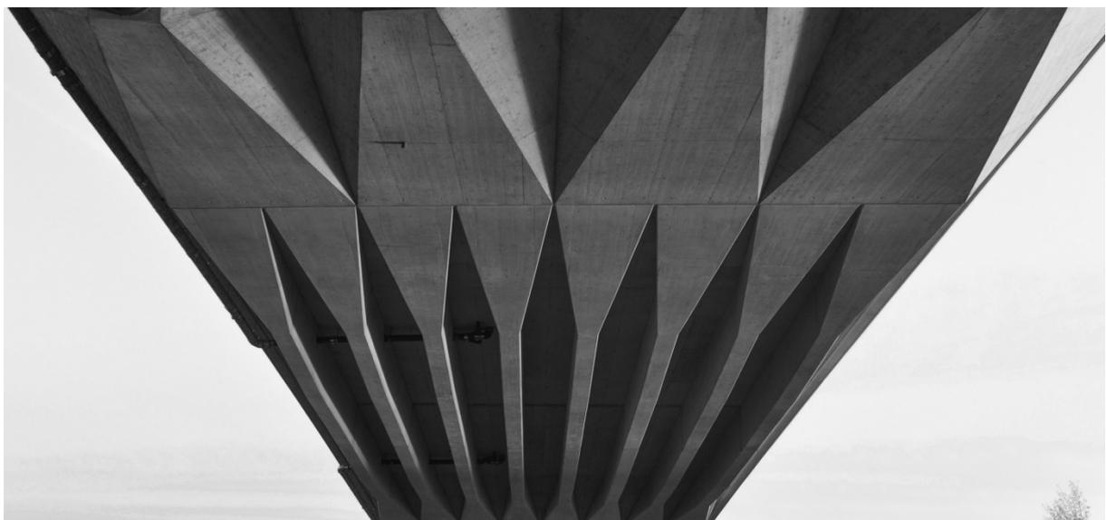
Abbildung A.2-3: In der Form nachvollziehbarer Kraftfluss durch Auflösung der Platte über die Anschlusskonsolen in einen Plattenbalkenquerschnitt (siehe auch Kapitel 7.2).
