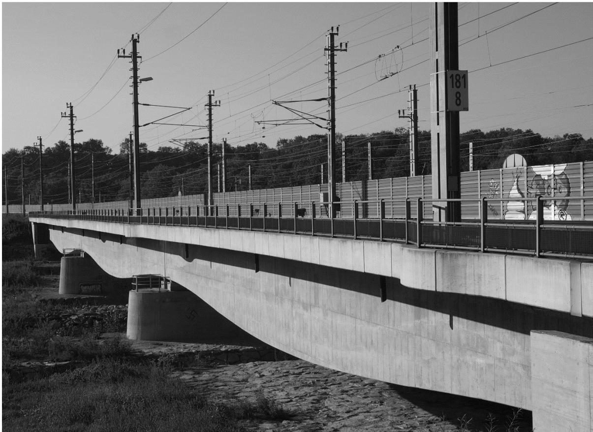
Abbildung A.2-7: Formgebung in Anlehnung an den Biegemomentenverlauf. Durch das dynamische „Eindrücken“ wird das Brückengewicht an den Auflagerpunkten deutlich. | © Erhard Kargel
