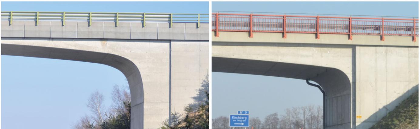
**Bild 13** Ein Vergleich der Proportionen des visuell abgesetzten Widerlagers und des Überbaus
