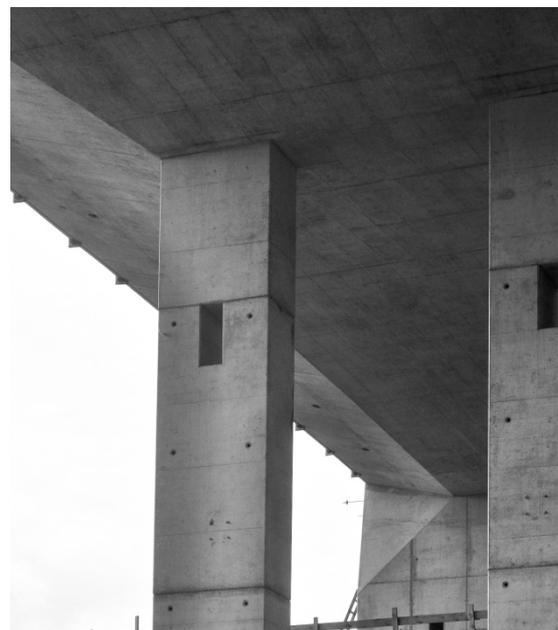
Abbildung A.2-5: Die formale Ausbildung der derzeit längsten geraden integralen Brücke Österreichs wurde mit einem gevouteten Trapezquerschnitt gelöst, der sich in den Widerlagern fortsetzt.
