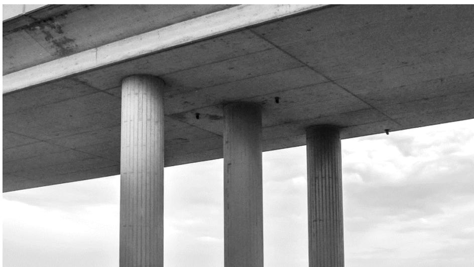
Abbildung A.1-1: Einfache, formlogische Stützenanschlüsse als getrennte Funktionseinheiten.
