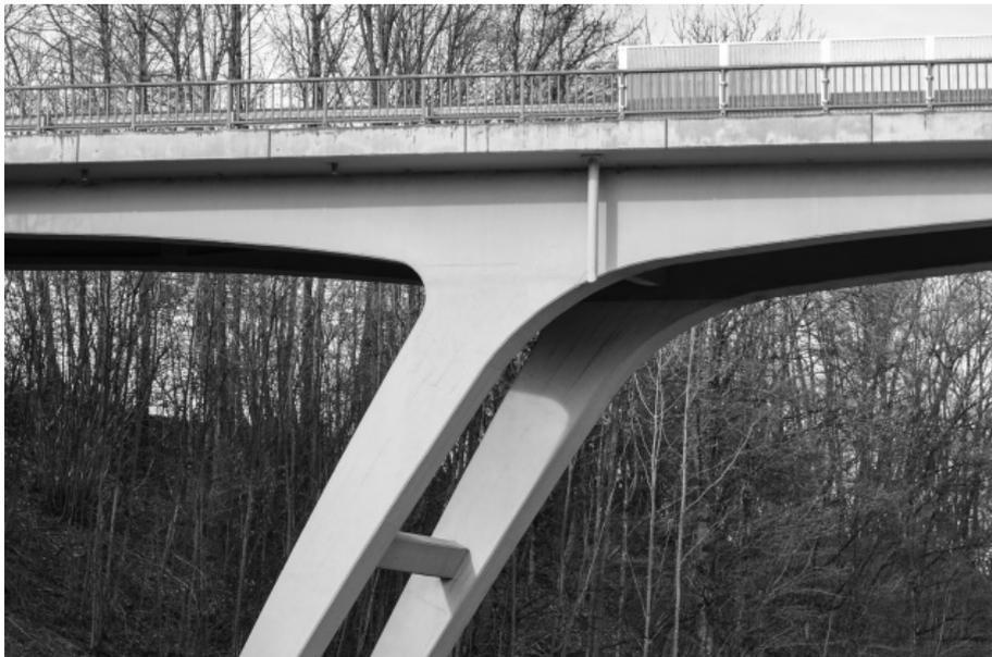
Abbildung A.1-4: Formlogischer Übergang der Plattenbalken in die Stiele. Hohe dynamische Ausdruckskraft durch die Schrägstellung, Ausrundung und der leichten Beugung der Stiele. Leider vermindern die nachträglich ergänzten Wasserableitungen den Formfluss.
