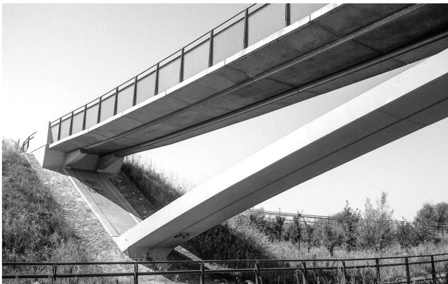
Abbildung A.1-10: Spannbandbrücke, bei der die Zug- und Druckelemente sowie der Kraftschluss an den Widerlagern deutlich in der Form herausgezeichnet wurden.
