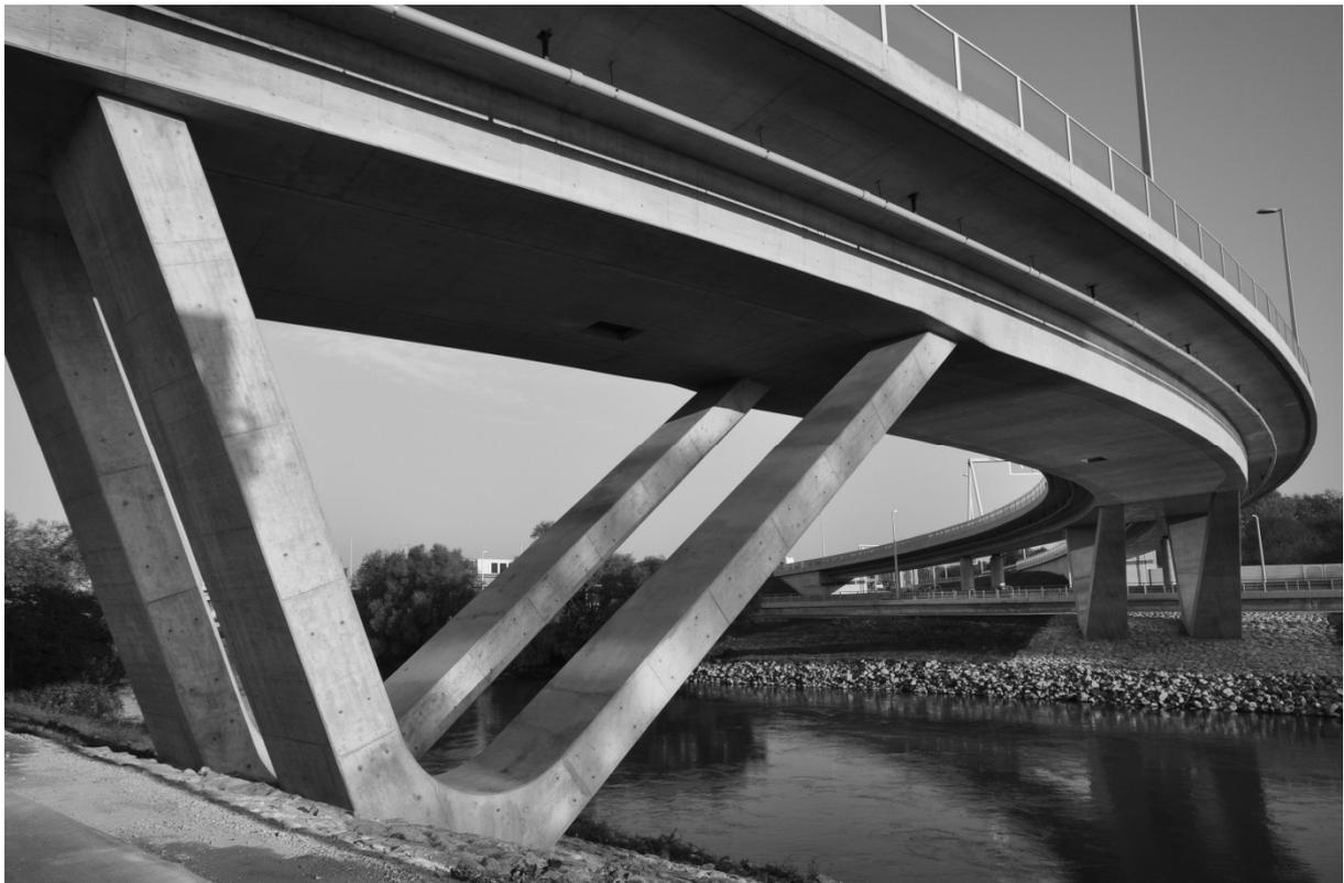
Abbildung A.2-4: Gekrümmter Hohlkasten mit V-förmiger Aufständerung als getrennte Funktionseinheit: Die steileren Stiele sind breiter gewählt, um dort Horizontalkräfte aus z.B. Erdbeben abzutragen.
