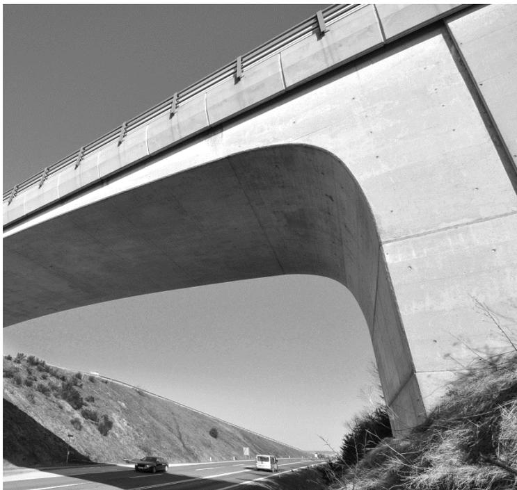
Abbildung A.1-5: Die Rahmenwirkung wird durch den Versatz zu den Widerlagerflügeln in der Form abgebildet.
