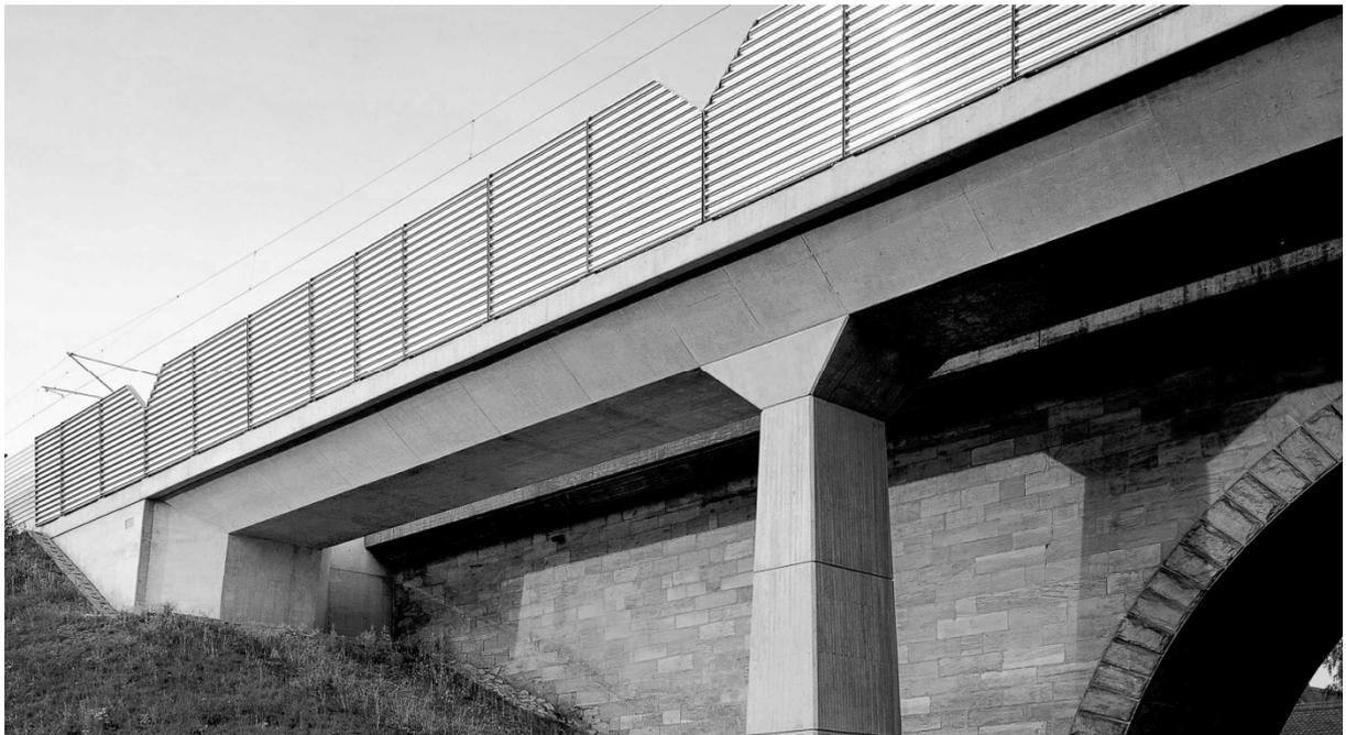
Abbildung A.2-8: Exzellente formale Ausbildung des Rahmenecks und der Stützeinspannung als werkstoffgemäßes Pendant zur Natursteinbrücke nebenan. | © ssf
