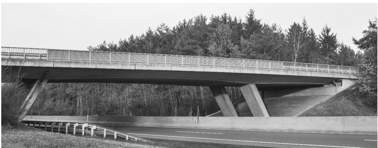
Abbildung A.1-3: Die kraftflussorientierte Ausformung der Platte zu den Streben einschließlich der Sichtkante zeugen von hoher individueller Qualität.
