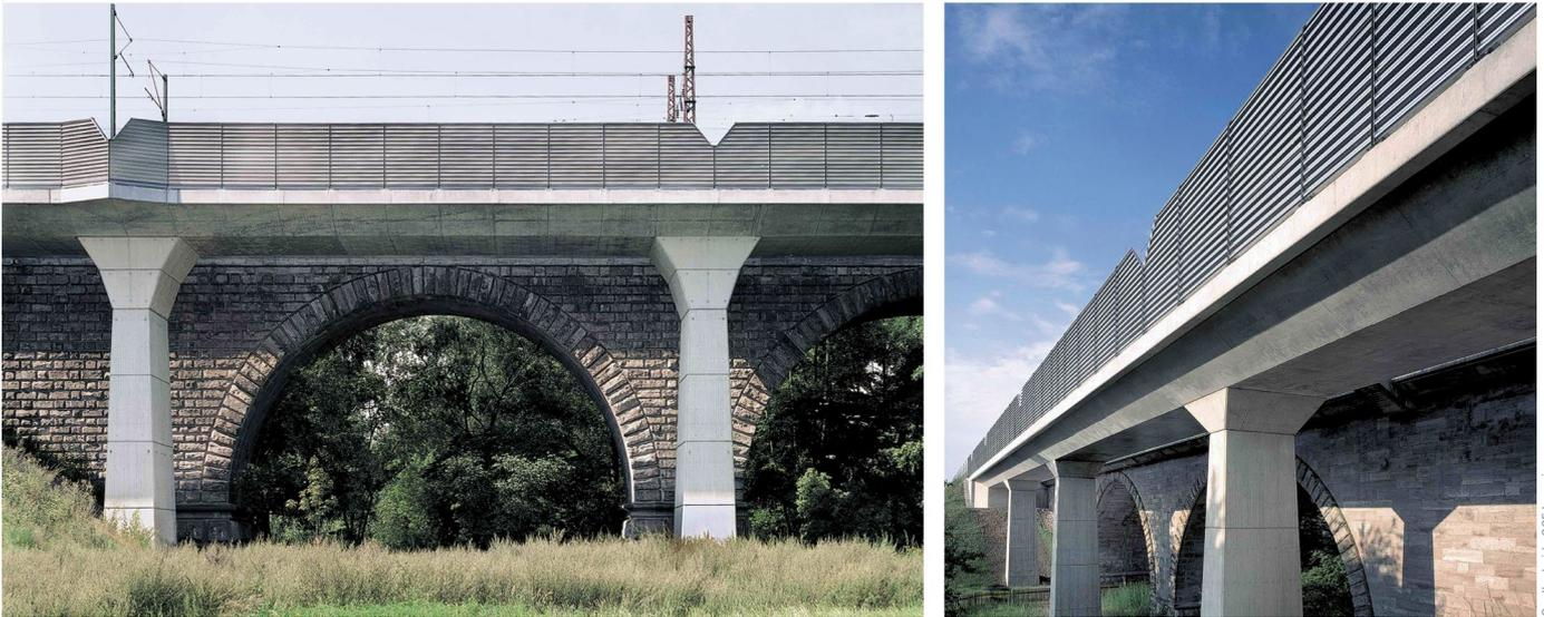
**Bild 2** Formhomogener Stützenanschluss im Natursteinbogen und die Reduktion auf die heute angewendeten gevouteten bzw. parallelgurtigen Bauformen (oben), Schwabachtalbrücke und Mainbachtalbrücke bei Nürnberg (unten, aus [15])
