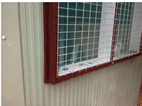
Abbildung 99 dokumentiert deutlich ein Fenster mit grobem Metallgitter. Es dient erstens als Einbruchsicherung und zweitens zum Schutz des dahinterliegenden ganz feinmaschigen Fliegenschutzgitters. Bei allen Fenstern und Außentüren ist ein Fliegengitter obligatorisch angeordnet.
