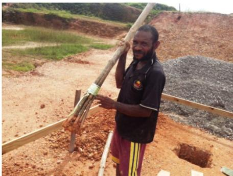
Abbildung 78 stellt einen Arbeiter im Einsatz mit einem selbstgebauten Werkzeug aus einer Holzstange dar. Die Stange ist an einem Ende in mehreren Teilen aufgespalten und dient zum Fördern des Erdmaterials aus dem Loch des Einzelfundaments.
