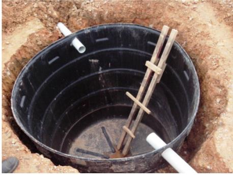
Abbildung 97 zeigt einen eingegrabenen Fäkalbehälter. Das anfallende Abwasser (Grau- u. Schwarzwasser) wird in diesen Behälter aufgefangen. Überlaufendes Wasser wird in einer natürlich bewachsenen Senke eingeleitet.
