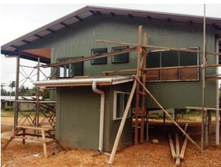
Abbildung 96 bildet die montierten weißen Dachrinnen aus Kunststoffrohren ab. Sehr oft wird das Dachwasser in großen Wassertanks gesammelt und dieses als 'Wasser-Hauptversorgung' verwendet. Im Bild ist auch ein kleiner Anbau, der als Waschküche dient, zu sehen.
