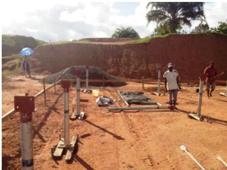
Abbildung 79 dokumentiert das Versetzen und Einbetonieren der Metallstützen. Es wird exakt gearbeitet, mittels Schnurgerüst der Lage betreffend, und mittels Nivelliergerät (oben links, unter dem blauen Regenschirm), welches die Höhe genau bestimmt.
