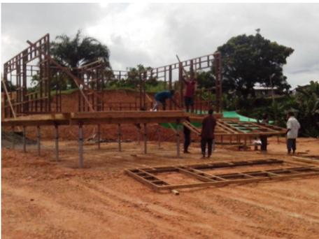
Abbildung 83 dokumentiert die Montage der vorgefertigten Holzrahmen der Wände. Diese werden Stück für Stück von Hand aufgestellt und nach Plan positioniert. Danach miteinander verbunden und auf der Bodenkonstruktion mit Nägeln fixiert.
