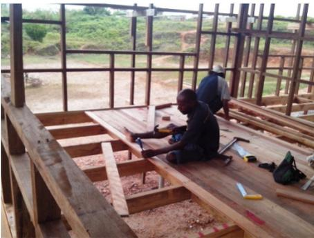
Abbildung 90 stellt das Verlegen der Bodenbretter dar. Entweder werden die Bretter vor dem Bezug abgeschliffen und versiegelt oder ein Bodenbelag wird verlegt. In diesem Fall wurde kurz vor Fertigstellung ein Boden aus 'PVC-Fliesen' aufgebracht.
