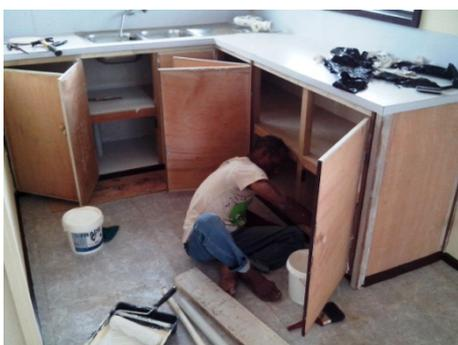
Abbildung 100 bildet bereits die letzten Arbeiten im Haus ab. Hier werden die Elemente der Küche fertig aufgebaut und noch mit weißer Farbe gestrichen. Die Küche ist mit einem Doppelspülbecken und einem Elektroherd (nicht im Bild) ausgestattet.
