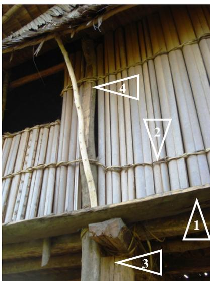
Abbildung 67: Detail (3): Abschluss Wandverkleidung und Einbindung der Wandkonstruktion (Quelle: privat, 15.12.2015)
