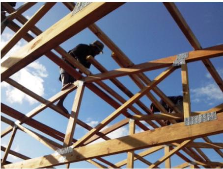
Abbildung 86 stellt eine Detailansicht des Fachwerkträgers der Dachkonstruktion dar. Diese werden so wie die Rahmen der Wände vorgefertigt und dann versetzt. Zur kraftschlüssigen Verbindung der Stabenden an Ober- und Untergurt werden Nagelplatten verwendet.
