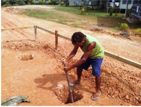
Abbildung 77 zeigt das Ausheben bzw. das Graben der Einzelfundamente für die Metallstützen. Es wird von Hand mit einer Eisenstange ein Loch gegraben. Für die Lage der Fundamente wurde zuvor ein Schnurgerüst aufgebaut.
