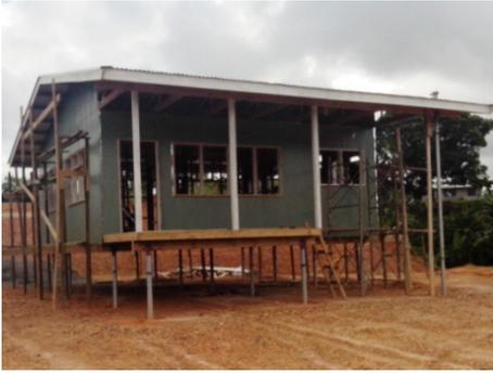
Abbildung 93 zeigt die in grün gehaltene Außenwandverkleidung aus Metall-Paneele, die auf die Holzunterkonstruktion genagelt werden. Die grüne Beschichtung dient als Korrosionsschutz. Die Verwendung von Blech ist ein wesentlicher Faktor für die Verlängerung der Lebensdauer des Gebäudes.
