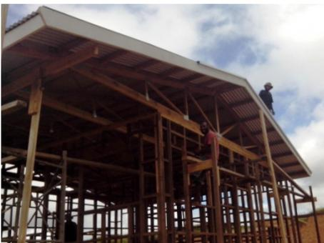
Abbildung 88 bildet die verlegten Blechpaneele der Dachhaut ab. Diese werden auf die Unterkonstruktion geschraubt oder genagelt. Eine Dachdeckung aus Blech ist der wichtigste Faktor in Bezug auf die Dauerhaftigkeit dieses Gebäudetyps.
