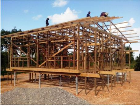
Abbildung 85 zeigt die bereits (auch von Hand) versetzten Dach-Fachwerksträger. Die Fachwerksträger werden in einem regelmäßigen Abstand positioniert, darauf werden Latten als Unterkonstruktion montiert, die dann für die Fixierung der Dachhaut benötigt werden.
