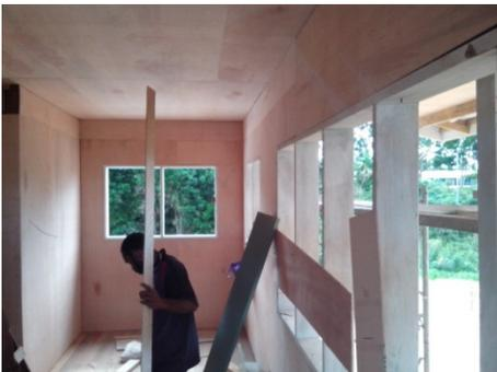
Abbildung 95 dokumentiert die Montage der Wandverkleidungen im Innenbereich. Am meisten verbreitet sind Sperrholzplatten als Verkleidung. Diese sind leider oft aus Weichholz oder aus minderer Qualität und daher nicht von sehr langer Lebensdauer.
