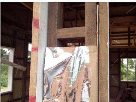
Abbildung 92 bildet eine aluminiumkaschierte Gewebbahn, die auf die Wandkonstruktion aufgebracht wird, ab. Darauf wird die Außenverkleidung aus Metall montiert. Diese Gewebbahn findet auch unter der Dachhaut ihre Verwendung.
