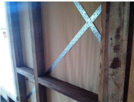
Abbildung 94 stellt eine Innenansicht der Außenwandkonstruktion dar. Zu sehen sind wieder Metallbänder, die die horizontalen Schubkräfte aus Wind und Erdbeben aufnehmen. Wie auch beim Dach sind diese Bänder das aussteifende Element in diesem Konstruktionsstyp.
