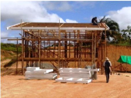
Abbildung 87 dokumentiert eine Außenansicht der konstruktiven Elemente. Die Fertigstellung der Dachkonstruktion endet mit der Montage der deutlich zu sehenden, in weiß gestrichenen, Ortgang- und Saumbretter.
