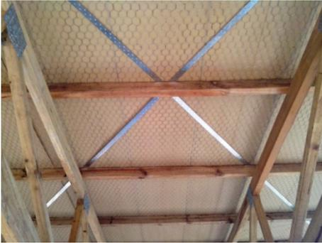
Abbildung 89 zeigt eine Ansicht der Unterseite der Dachhaut. Zu erkennen ist eine Gewebbahn (an oberer Seite mit Aluminium kaschiert), die als 'Hitzeschutz' fungieren soll. Die Auskreuzung mittels Metallbändern wird als Schubverband des Gebäudes eingesetzt.
