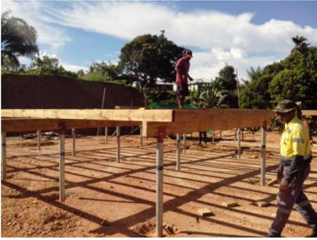
Abbildung 81 zeigt die bereits verlegten Sekundär- bzw. Querbalken der Bodenkonstruktion. Die Dimension der Balken ist kleiner und auch der Abstand ist geringer als die der Hauptbalken.
