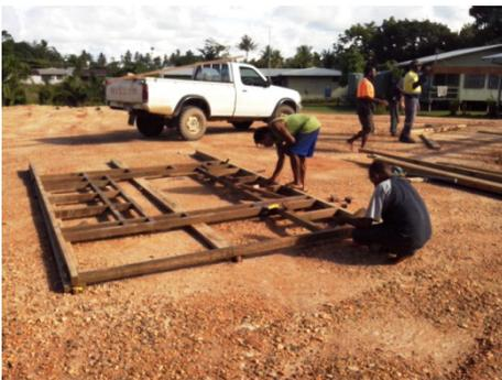
Abbildung 82 stellt die Fertigung der Holzrahmen für die Wände des Gebäudes dar. Diese werden zuvor auf einer ebenen Fläche anhand von genauen Plänen vorfabriziert. Es wird auf die Abmessungen der Elemente und auf die einzubauenden Türen und Fenster
