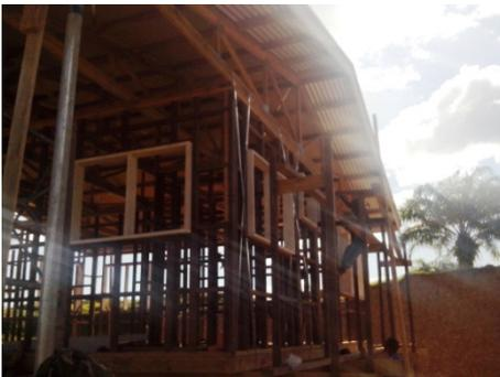
Abbildung 91 dokumentiert die versetzten Rahmen für die Fenster. In diesen Rahmen werden in der Ausbauphase die Schienen für die Fenster montiert. Es handelt sich hierbei um Fenster aus horizontal kippbaren Glaselementen, wie es oft auch in Australien üblich ist.
