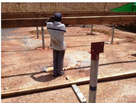
Abbildung 80 bildet die Montage der Hauptbalken der Bodenkonstruktion des Hauses ab. Diese werden mit zwei Metallbolzen an den Winkeln, welche auf den Metallstützen angeschweißt sind, verschraubt.
