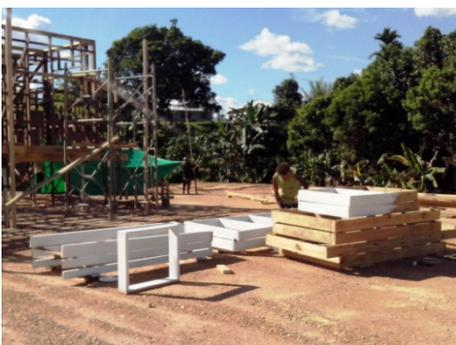
Abbildung 84 bildet die Vorfertigung der Rahmen für Fenster und Türen ab. Diese werden im späteren Ausbaustadium zum Versetzen der Fenster und Türen benötigt.
