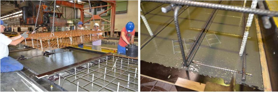
Abbildung 4.7.: Betonieren der ersten Wandplatten aus UHPC (links) und Einsetzen der Bewehrungskörbe (rechts)
