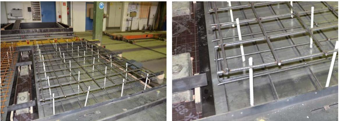
Abbildung 4.2.: Bewehrungskorb Prototyp 2 - Ø10/20mm
