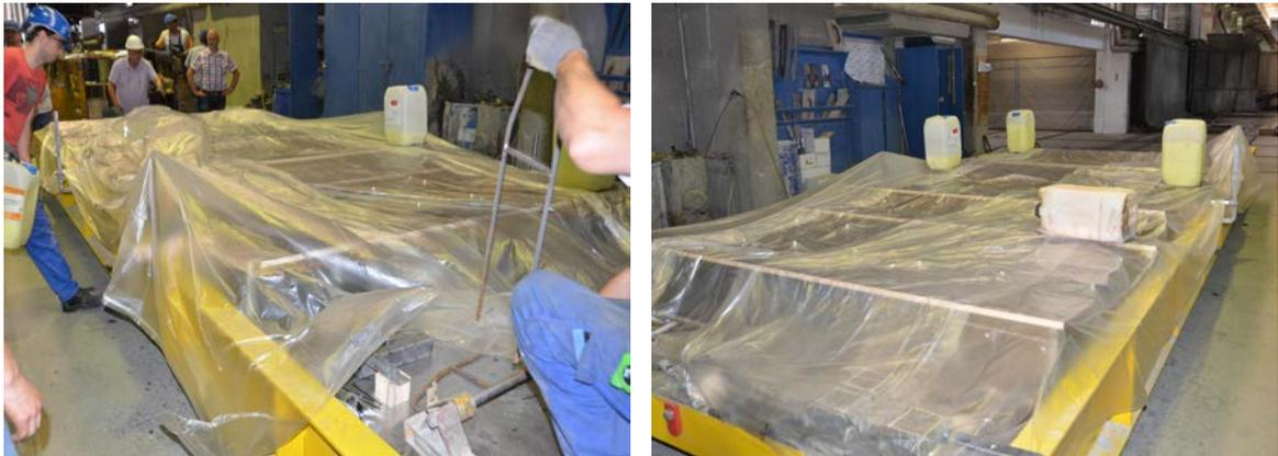
Abbildung 4.9.: Abdeckung mit einer dampfdichten Kunststoffolie
