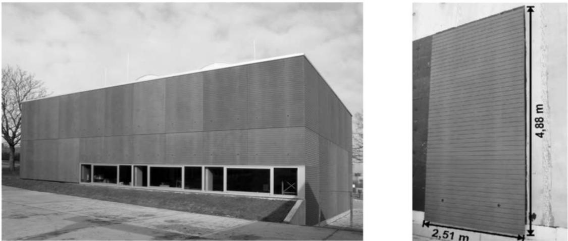
Abbildung 2.9.: Ansicht der Südfassade (li.) und Ansicht der einzelnen Fassadenplatten (re.) [18]
