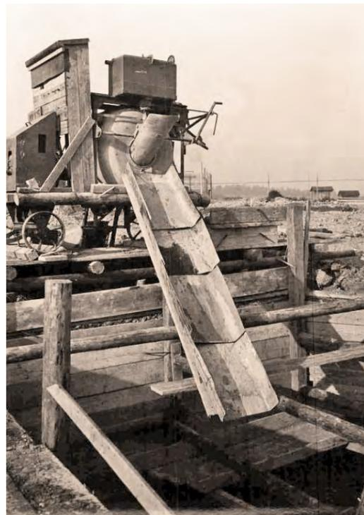
abb.10 | betonmischmaschine
