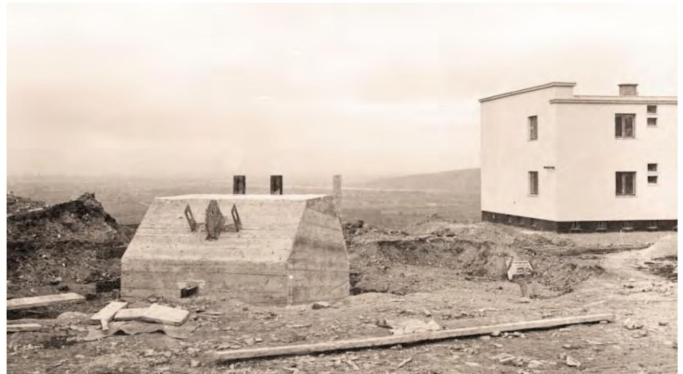
abb.14 | fundament für halteseile des sendemastes
