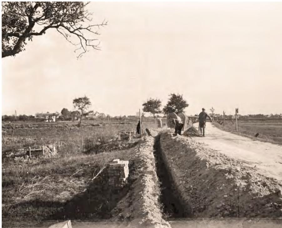
abb.09 | kabelverlegung zum sender
