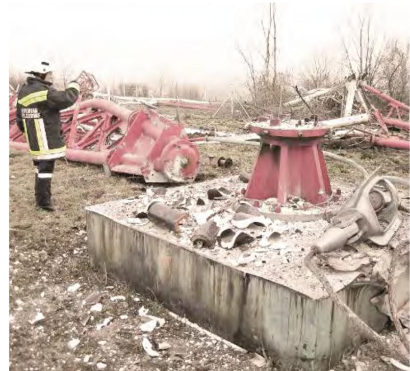
abb.35 | gesprengtes sendermastfundament
