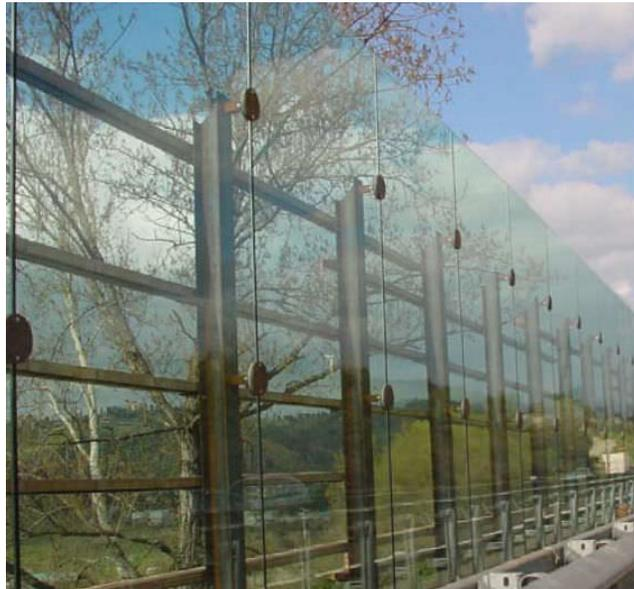
Abb. 94 Vorbild für Stahl-Glaswand- eine Autobahnlärm-schutzwand
