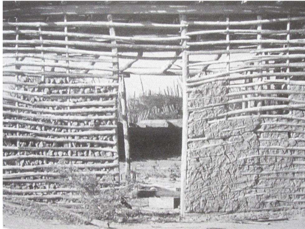
Abb.4.50: Wände aus Nasslehmverfüllung
