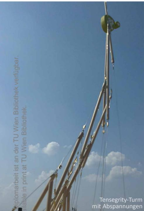
Tensegrity-Turm mit Abspannungen
