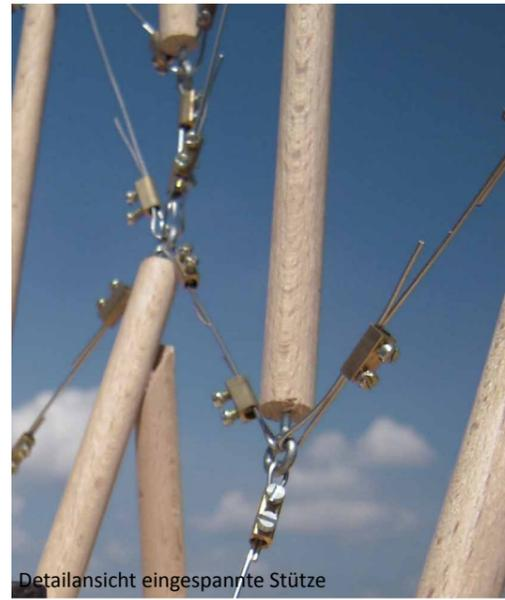
Detailansicht eingespannte Stütze
