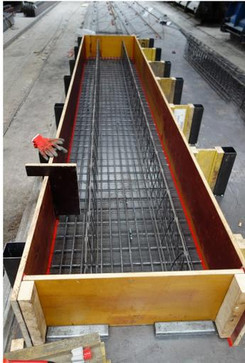
(a) Bewehrung der Fertigteilplatte
