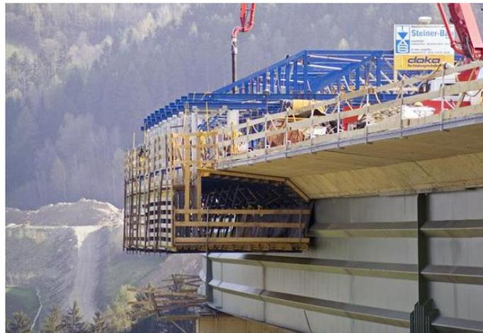
Abbildung 2.1.2.: Verbundschalwagen der Firma DOKA am Beispiel des Talübergangs Auenbach [46]
