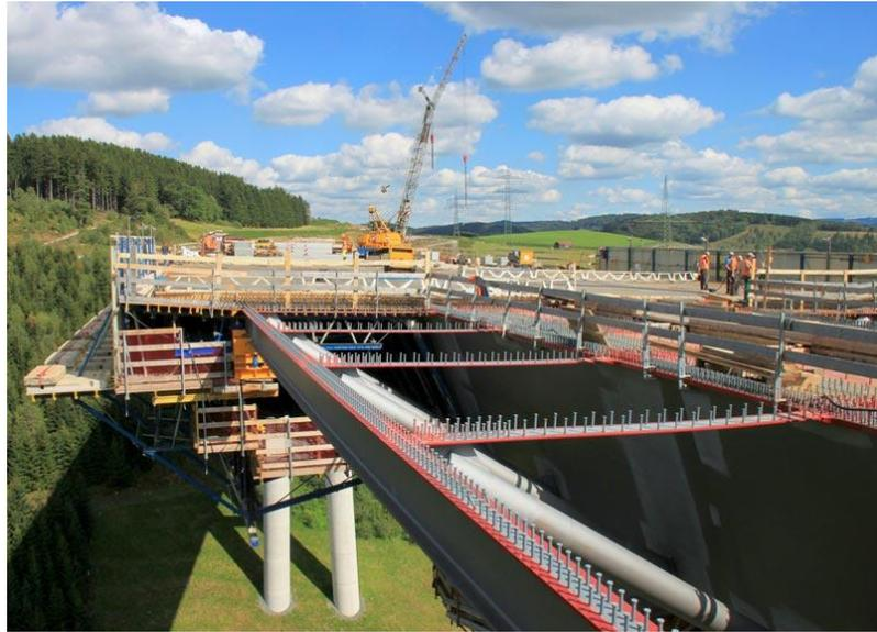
Abbildung 2.1.3.: Untenliegender Verbundschalwagen der Firma DOKA am Beispiel des Talübergangs Nuttlar [44]
