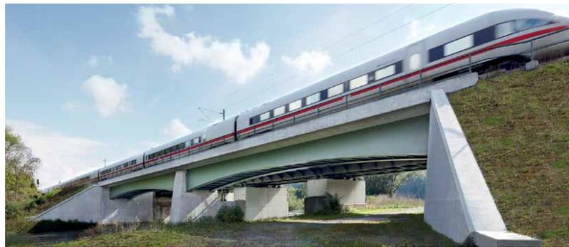
Abbildung 1.0.2.: Stahl-Beton-Verbundbrücke am Beispiel der VFT<sup>®</sup>-Bauweise [34]
