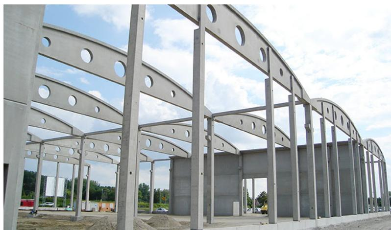
Abbildung 1.0.1.: Beispiel einer Hallenfertigung mit Stahlbetonfertigteilen [40]
