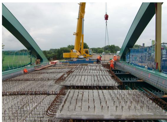
Abbildung 1.0.3.: Einsatz von Stahlbeton-Halfertigteilen am Beispiel der Straßenbrücke Horsterdamm [32]
