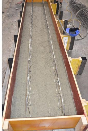
(b) frisch betonierte Fertigteilplatte
