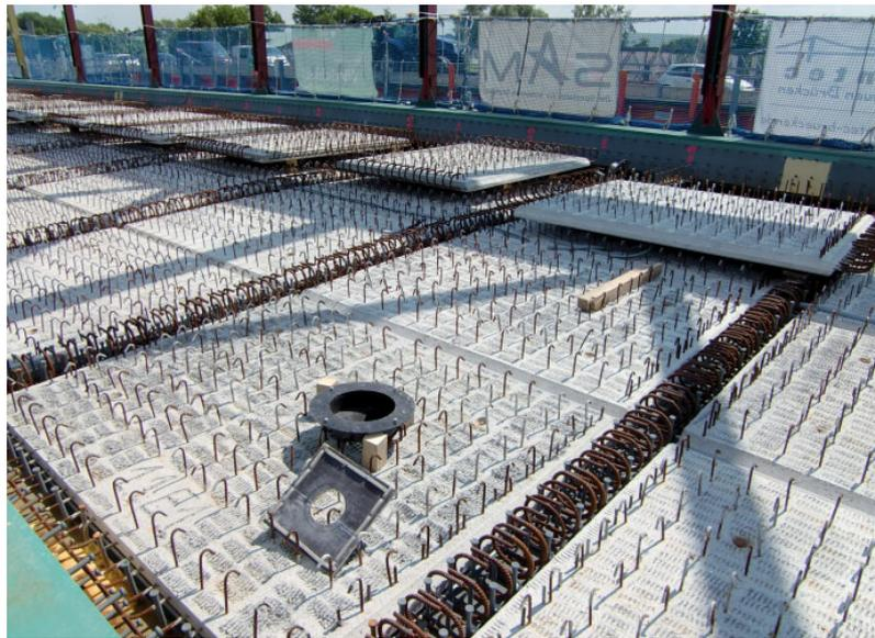
Abbildung 2.2.4.: Verlegte Fertigteilplatten der Straßenbrücke Horsterdamm vor Einbringen der Aufbetonschicht [24]
