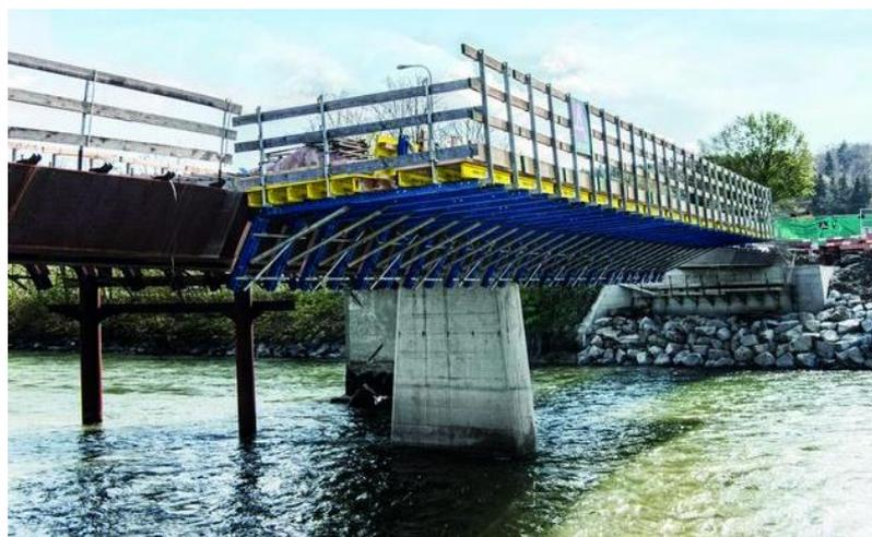
Abbildung 2.1.1.: Brückenschalungssystem PARATOP der Firma DOKA am Beispiel der Brücke Rathausen [35]
