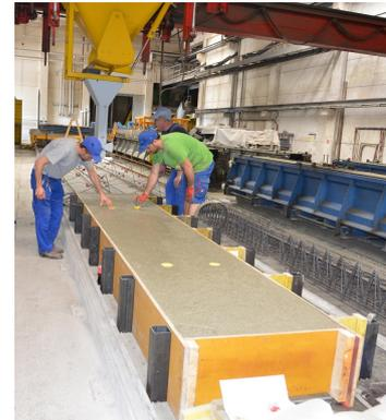
(c) frisch betonierte Aufbetonschicht
