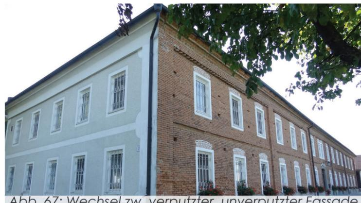
Abb. 67: Wechsel zw. verputzter, unverputzter Fassade
