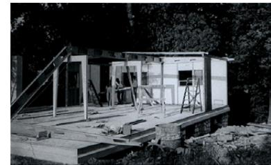
5.12 Montage des Haustyps Standard: Umgekehrtes „U“ als Rahmen im Innenraum erkennbar
