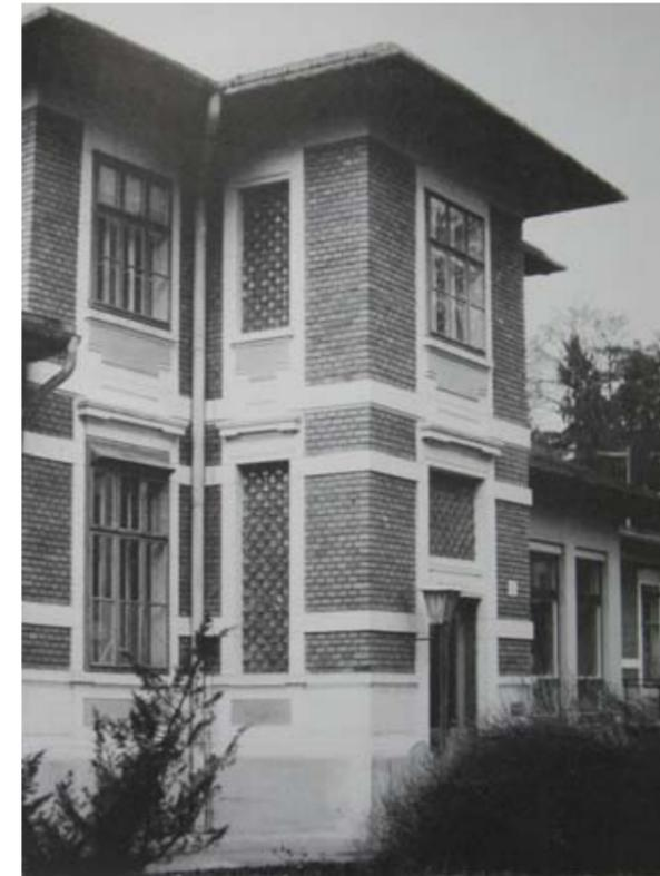
Abb.:2.11 Pavillon mit Sichtziegelmauerwerk in Mauer- Öhling
