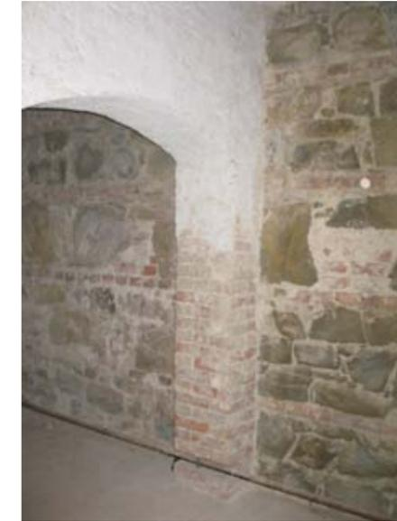
Abb.: 3.6 Gewölbe parallel entlang des Festsaaes, hier ist das ursprüngliche Mauerwerk noch teilweise sichtbar
