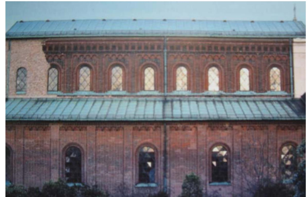
Abb.: 3.44 München, St. Bonifaz, Westseite; die Reparaturarbeiten sind im linken oberen Teil der Fassade eindeutig zu erkennen. (Foto 1985)
