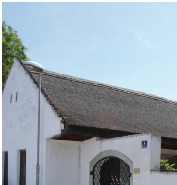
Abb.344 Satteldach mit Schilfdeckung
