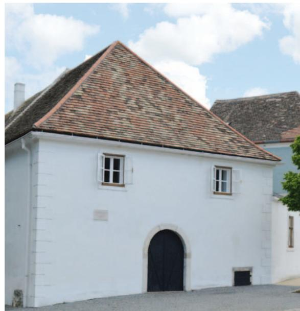
Abb.219 Dachziegel mit natürlicher Alterung
