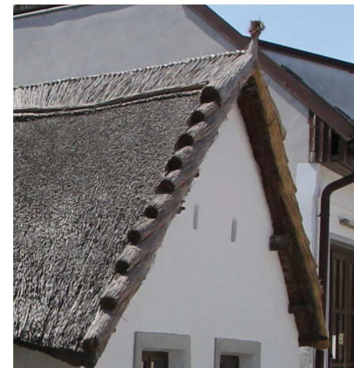
Abb.21 Randabschluss eines Schilfdaches - Stufenziegel
