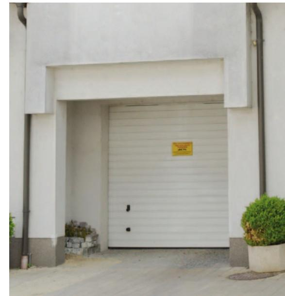
Abb.217 Rolltor ohne Kontrast und hinter der Mauerflucht
