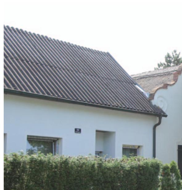
Abb.346 Dachdeckung aus Welleternit
