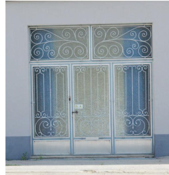
Abb.216 Dreiteiliges Tor aus Metall und Zierrat
