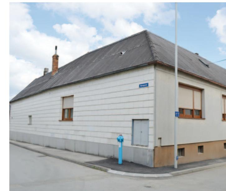
Abb.254 Fassadenverkleidung aus Eternit auf traditionellem Bau
