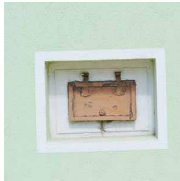
Abb.114 Kellerbelüftungsöffnung mit Eisenklappe
