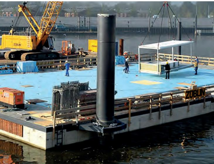
Abb. 79 | 80 Pontonfixierung mittels Stahlpylon
