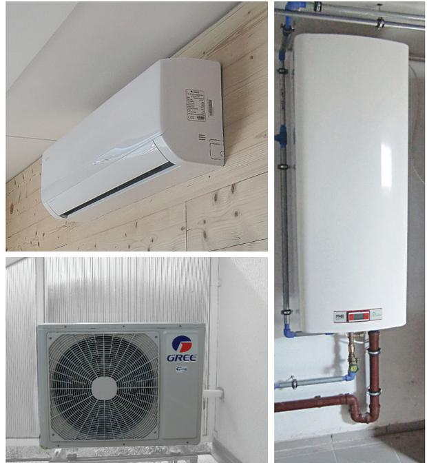
Abbildung 3.20: oben links: Klimagerät innen; unten links: Klimagerät außen; rechts: Boiler
