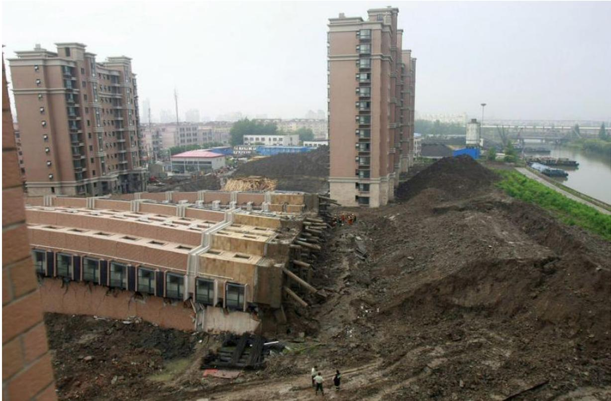
Abb. 11: Ein aufgrund falscher Simulation des Bodens gekipptes Hochhaus [2]
