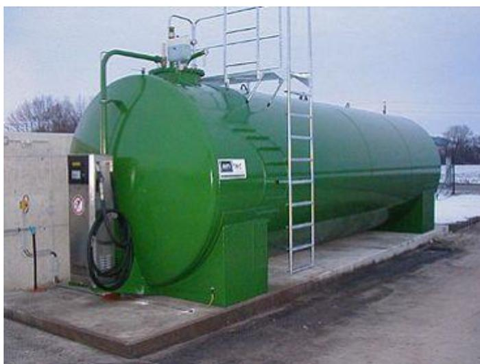
**Abbildung 22: Beispiel einer oberirdischen Betriebstankanlage<sup>190</sup>**
