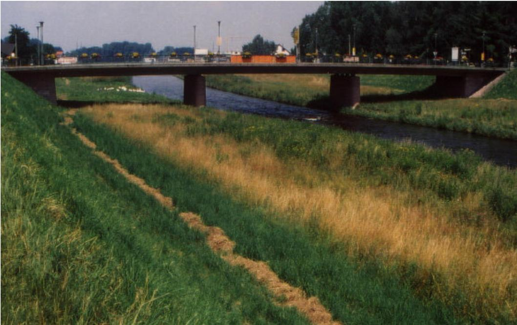
Abbildung 3.22: Böschung bzw. Vorland (Gras, Wiese):  $k_{St} = 30 \text{ m}^{1/3}/\text{s}$  (entnommen aus [KNAUF, 2003], S. 34)
