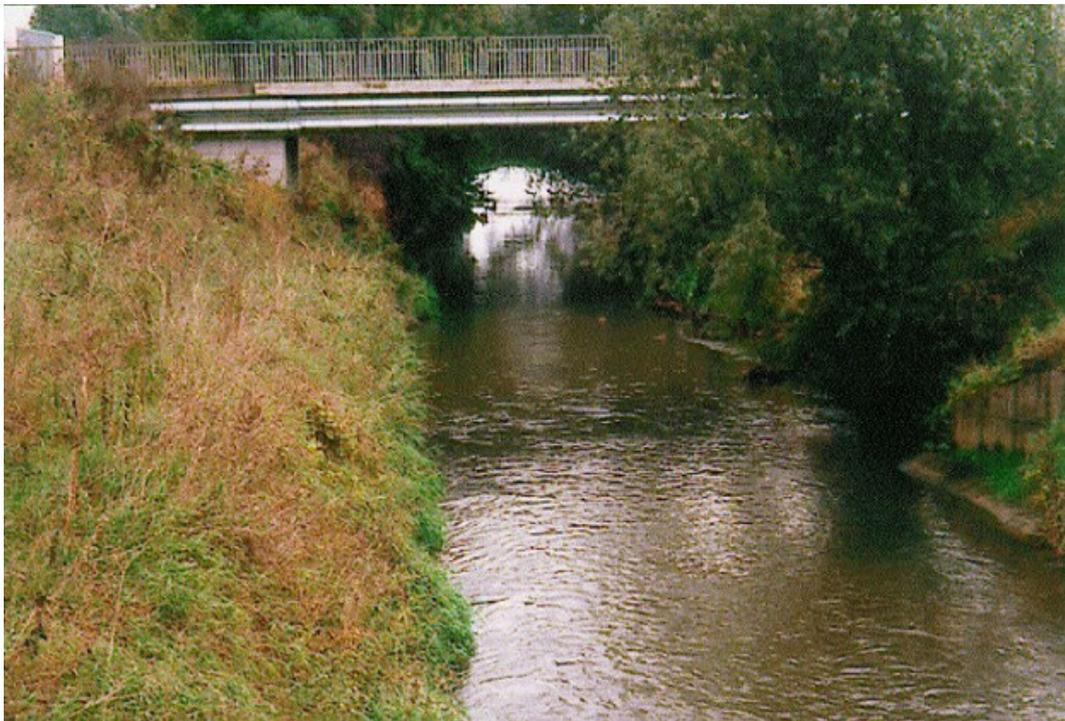
Abbildung 3.25: Böschung (krautiger Bewuchs):  $k_{St} = 22 \text{ m}^{1/3}/\text{s}$  (entnommen aus [KNAUF, 2003], S. 38)
