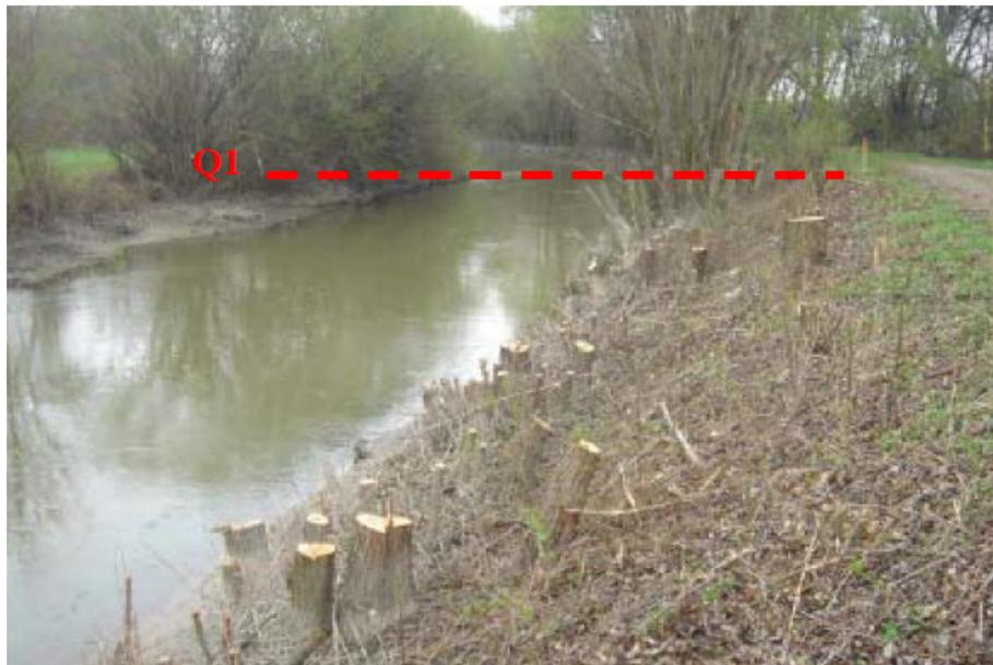
Abbildung 5.6: Querschnitt des Russbaches im Frühjahr 2005 – auf Stock geschnittener Böschungsbewuchs -  $k_{St}$ -Wert = **28 bis 33  $m^{1/3}/s$**  (entnommen aus [PAUGAM, 2008], S. 45)
