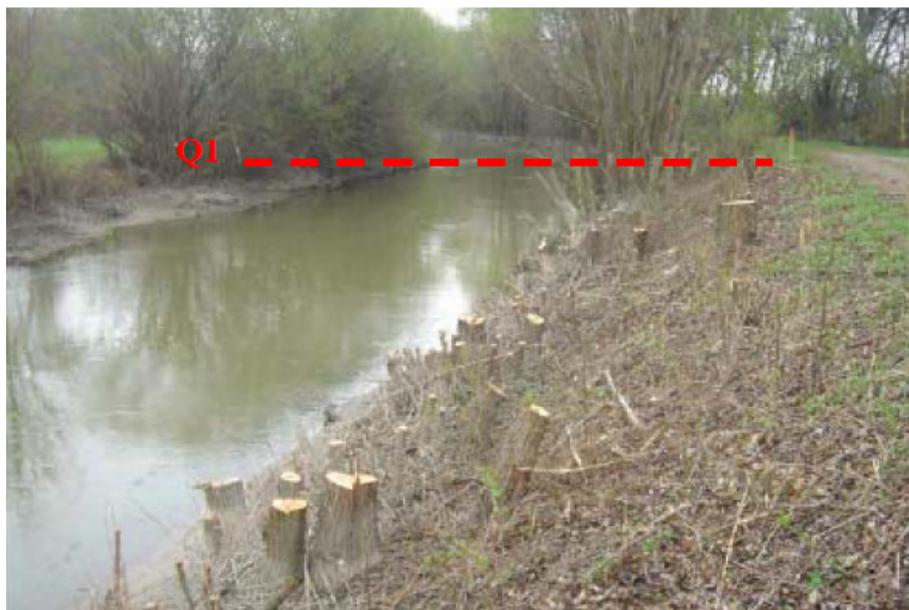
Abbildung 3.29: Querschnitt des Russbaches im Frühjahr 2005 – auf Stock geschnittener Böschungsbe-
