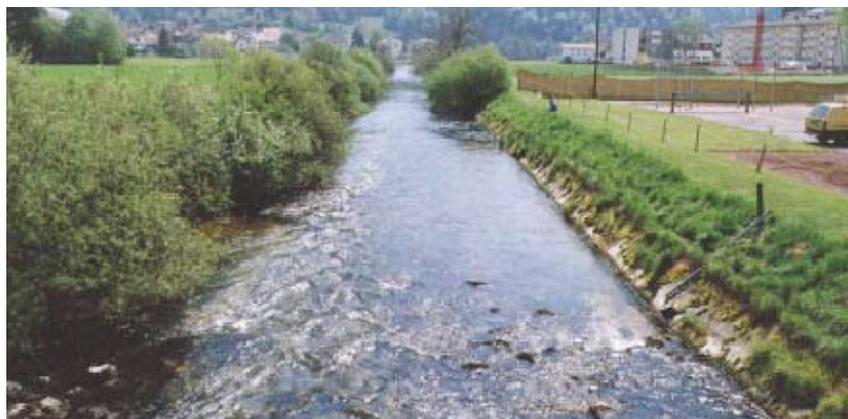
Abbildung 3.14: Versuchsstrecke Suze - Sonceboz, Sohlbreite ca. 10 m; Foto: Fluss in Fließrichtung betrachtet; Abflussmenge 2,4 m<sup>3</sup>/s (entnommen aus [SPREAFICO/ HODEL/ KASPAR, 2001], S. 37 ff.)
