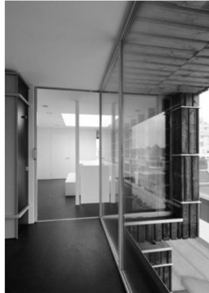
wurden. Eine Kabelfirma hat ausrangierte Kabelrollen zur Verfügung gestellt. Das Kernstück dieser Rollen sind Holzlatten, die normalerweise als Brennholz verwertet werden. Diese Holzlatten waren unversehrt und durch ihre Standardgröße ideal für die Fassadenverkleidung. Glasabfall einer Glasfabrik konnte weiters für die Fassaden verwendet werden.
