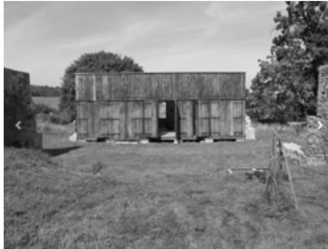
Die Vorgaben für die Planung dieses Gebäudes waren u.a. geringste Kosten zu erzielen, die durch die maximale Nutzung lokaler Materialien und Möglichkeiten gewährleistet war. Die ursprüngliche Scheune wurde bis auf die massiven Aussenmauern abgerissen. Diese
