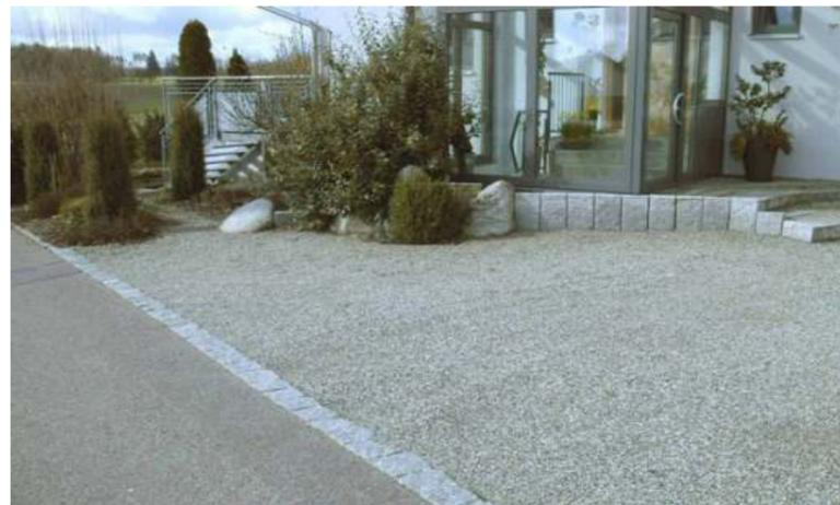
Abb. 119: Wassergebundene Decke
