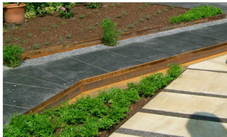
Abb. 120: Rasenkante aus Corten-Flachstahl
