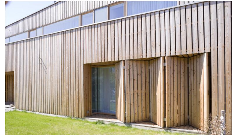
Abb. 102: Vertikale Leistenschalung
