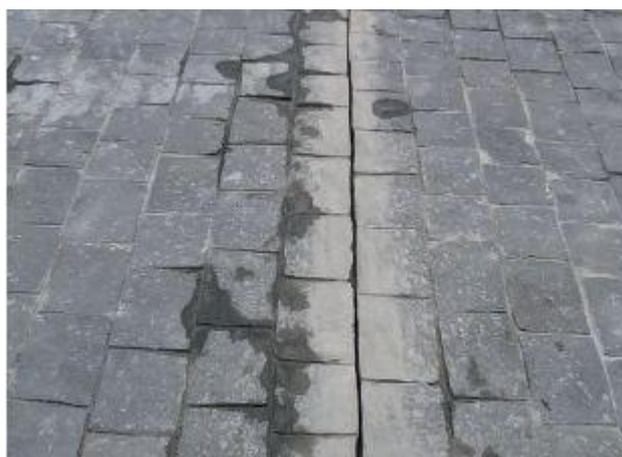
**Abbildung 30: Mittels Flex geöffnete Bewegungsfuge im Straßenbelag (max. die obersten 30 mm des Fugenmörtels entfernen) [17]**
