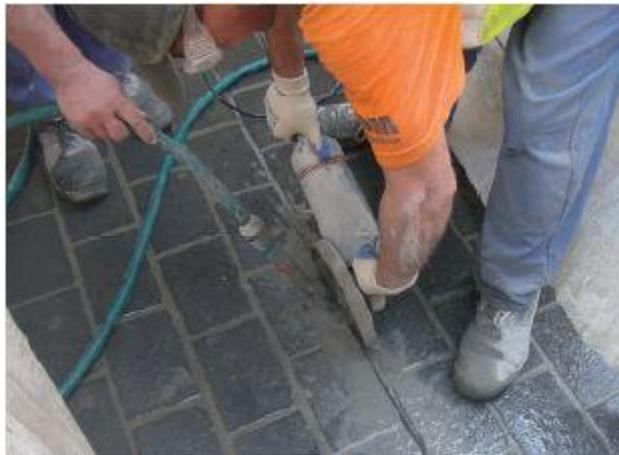
**Abbildung 29: Einschneiden der Bewegungsfugen – einige Tage nach dem Verlege- und Verfugungsprozess [17]**
