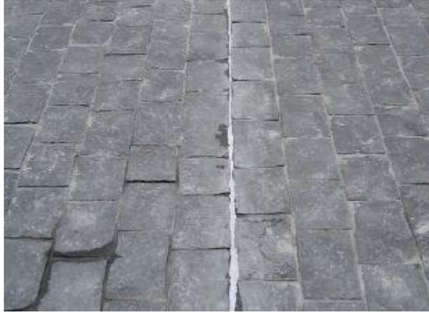
**Abbildung 31: Verfüllen des Einschnitts mit einem elastischen Dichtstoff [17]**
