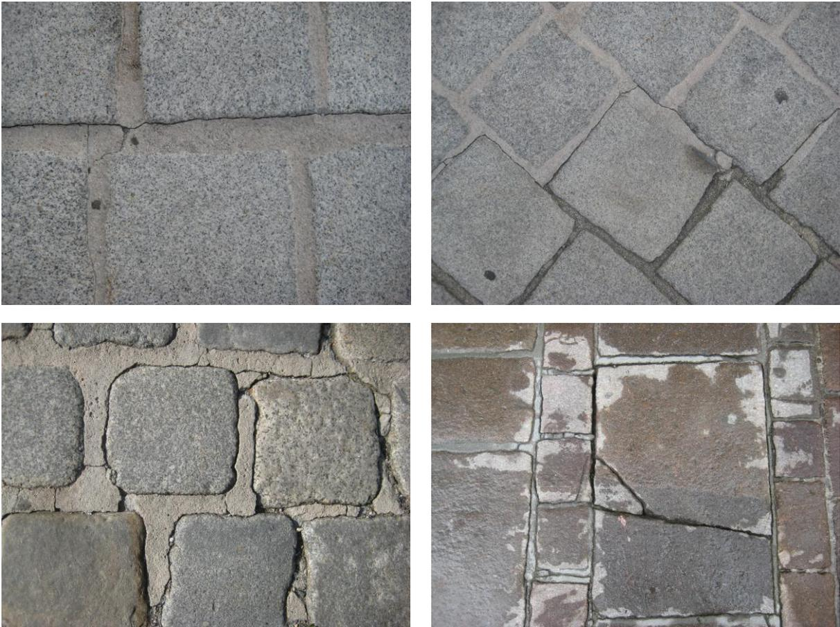
**Abbildung 20: Schadensbilder: Fugenmörtel vom Pflasterstein abgerissen**
