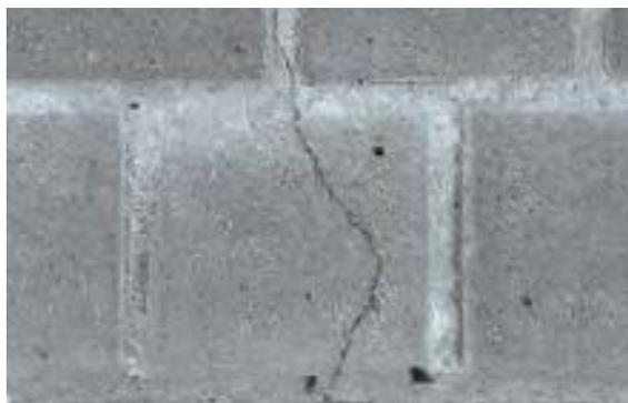
Abbildung 22: Schadensbilder: Rissverlauf in Stein und Fuge (Betonpflaster) [17]
