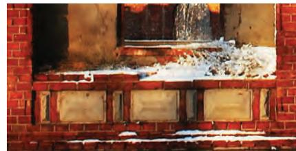
Abb.97 Beschädigte Fensterbank
