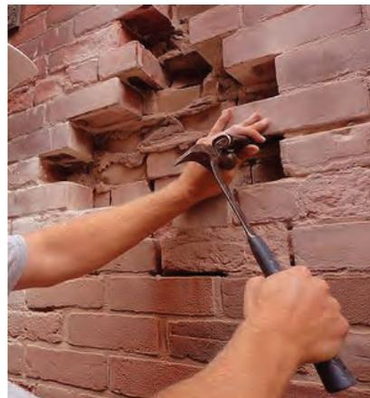
Abb.146 Verfahren für Neuverfugung/Bindemittelergänzung
