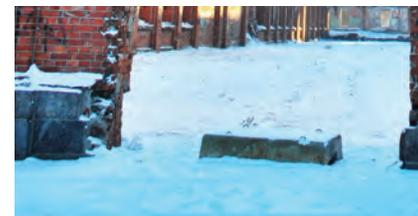
Abb.94 beschädigter Granitsockel
