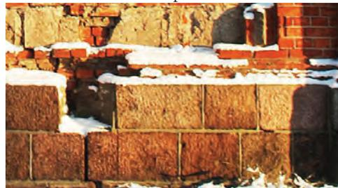
Abb.103 Anschluss zum abgerissenen Kesselhaus
