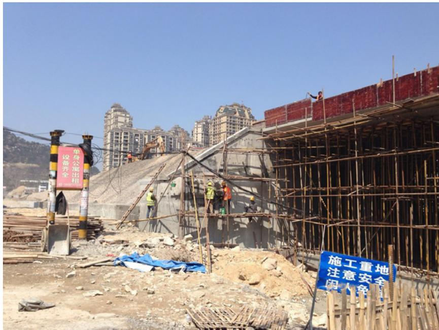
Abb.22: Baugerüste bestehen aus Bambusrohren<sup>38</sup>
