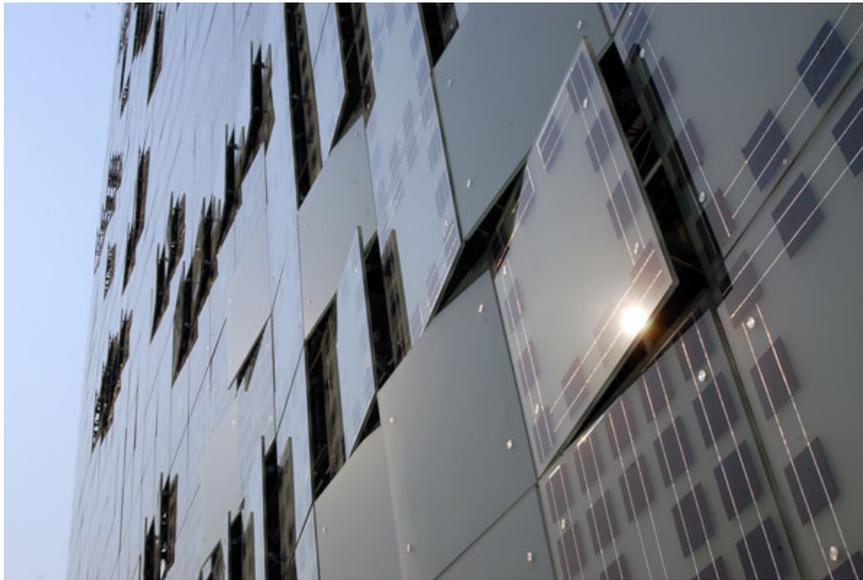
Abb.48: LED+Photovoltaik, GreenPix<sup>69</sup>
