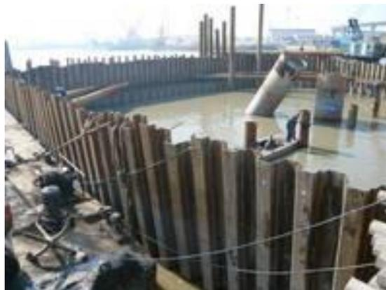
Da der Untergrund aus felsigem Gestein bestand, konnten die Spundwände nicht wie üblicherweise in den Boden getrieben werden. Stattdessen wurden sie in den felsigen Untergrund einbetoniert, um ausreichend Halt und Seitenunterstützung zu gewährleisten. Dazu wurden zusätzliche Gräben ausgehoben. An der vierten Seite der Grube zum offenen Meer hin, setzte man drei herausnehmbare Stahlwände ein. Somit konnte der
