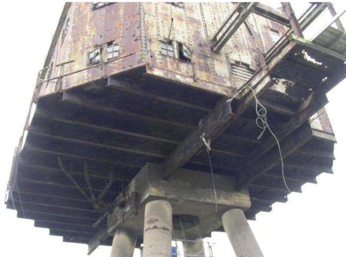
Die Kombination von Korrosion und extremen Witterungsverhältnissen führt zudem dazu, dass einige Paneele der Dachbrüstung ausbrechen.<sup>72</sup>
