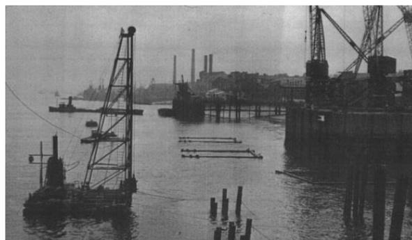
Nun wurde immer der unterste Teil eines Pfeilers am Fundament montiert, wobei jeweils am oberen Ende angebrachte Stahlringe dazu dienten, den Teil der montierten Säule zur Unterstützung am Gerüst zu befestigen.
