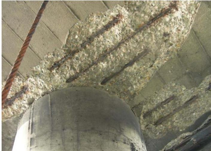
**Abb. 42: Freigelegte Bewehrung an einem Stützpfeiler**
