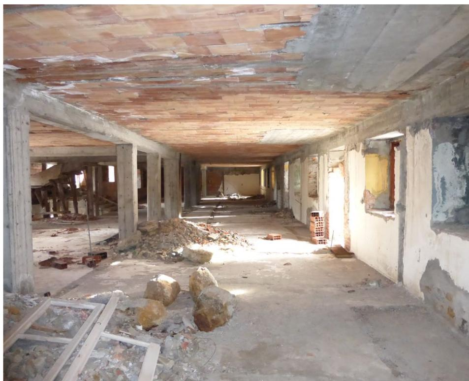
Abb. 203. das 4. Obergeschoss: die Trennwände werden entfernt, in den Fensterlaibungen sind Farbreste erkennbar.
