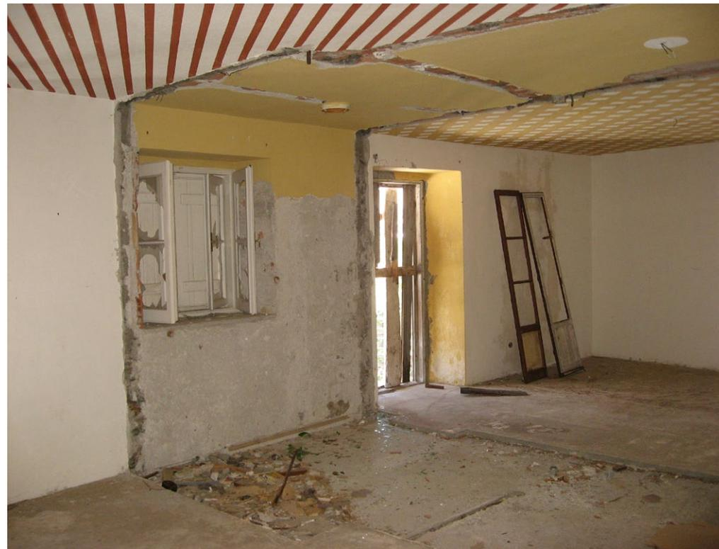
Abb. 201. Die Trennwände zwischen den Zimmern 8 und 9 werden entfernt
