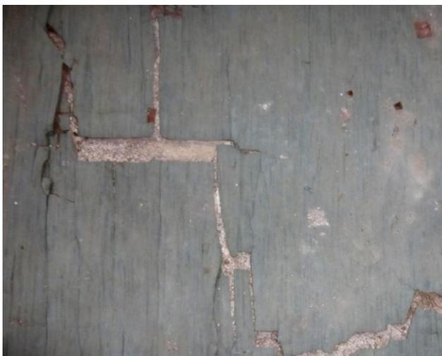
Abb. 232. spröder, gestreifter Linoleumboden
