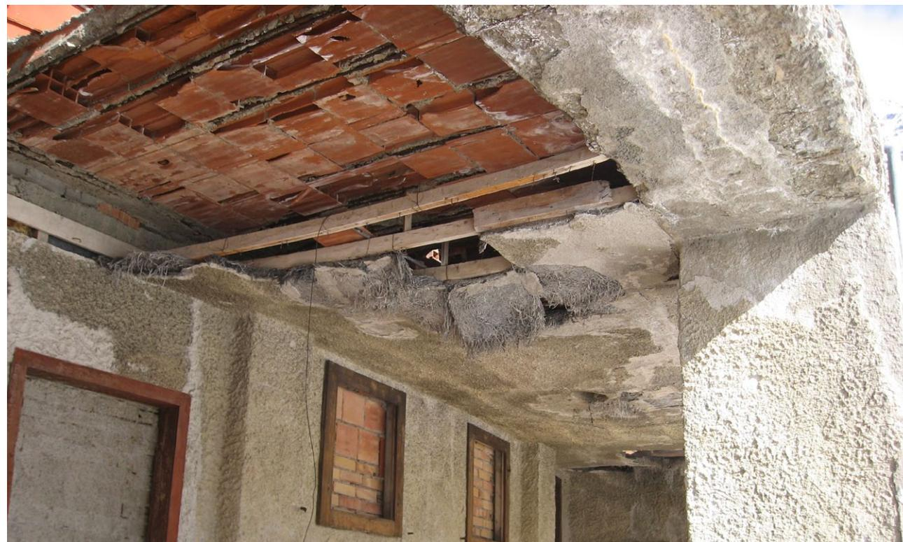
Abb. 229. abgehängte Decke unter der Terrasse 1937
