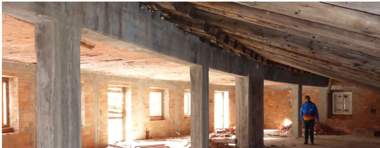
Abb. 224. der STB- Träger der Mittelachse als Auflager der Sparren
