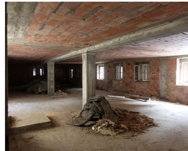
Abb. 206. Zubau, 2.OG, der mittigen Stahlbetonstützen
