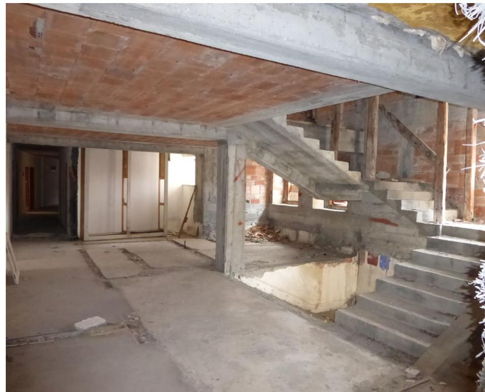
Abb. 202. Im Treppenvorraum des 3. OG werden die Trennwände teilweise entfernt
