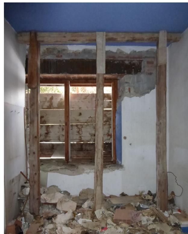
Abb. 259. die Fenster wurden vergrößert, der Schutt nie entfernt
