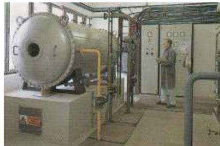
Abbildung 61 Ionisierende Einheit
