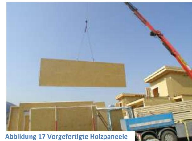
Abbildung 17 Vorgefertigte Holzpaneele
