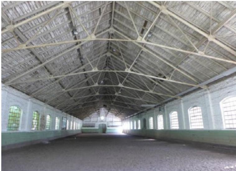
Abb.5.9 / Stahlfachbinder
