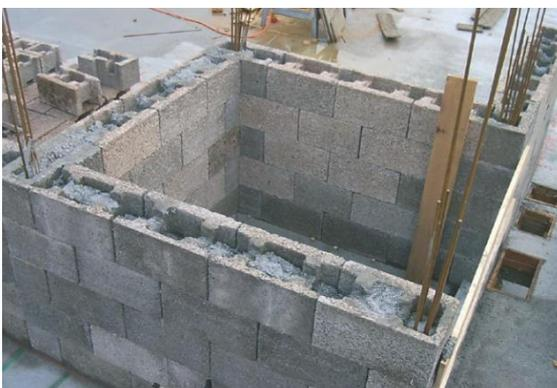
Abb. 2.17: Einsatz der Schalsteine als Liftschacht [14]
