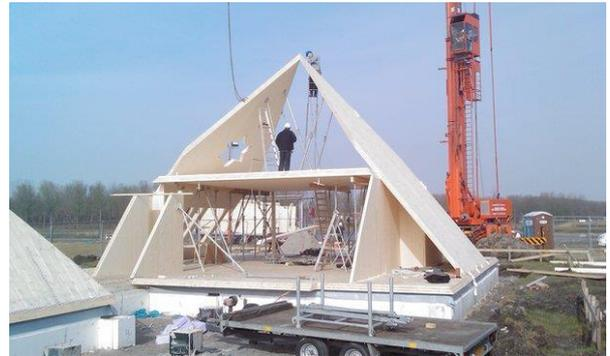
Abb. 2.11: Kreuzlagenholzpyramide, Niederlande – Prototyp eines Wohnhauses [11]
