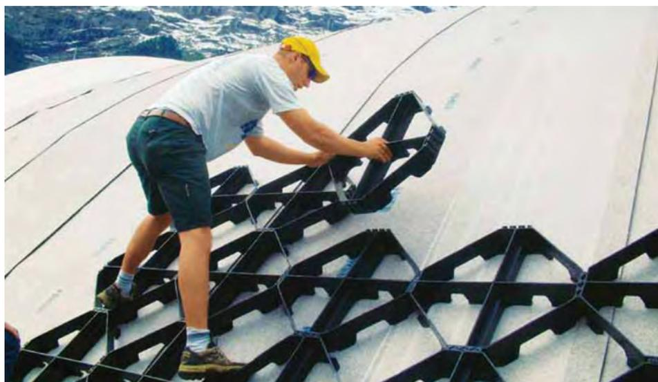
Abb.90 Einsetzen von Rasterelementen
