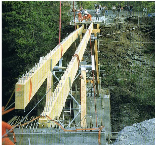
ABB.27 Verbundsystem aus Brettschichholzträgern und Beton
